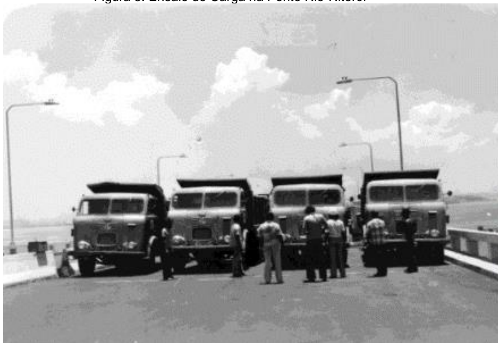
Figura 3. Ensaio de Carga na Ponte Rio-Niterói
