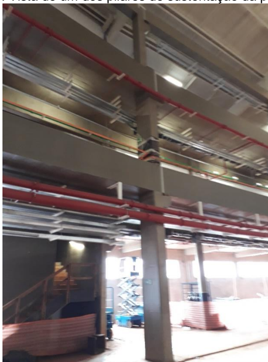
Figura 104. Vista de um dos pilares de sustentação da ponte rolante
