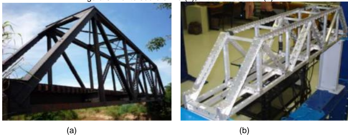
Figura 6. Ponte sobre o Rio (a); Modelo reduzido (b)
