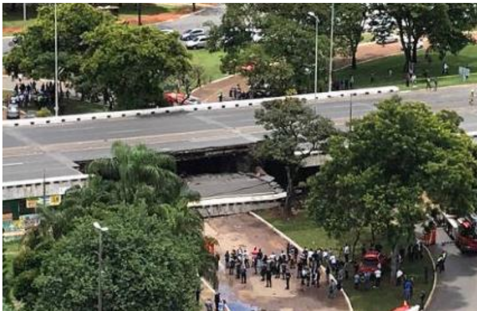
Figura 1. Desabamento de trecho do Viaduto do “Eixão” Sul (Brasília-DF)
