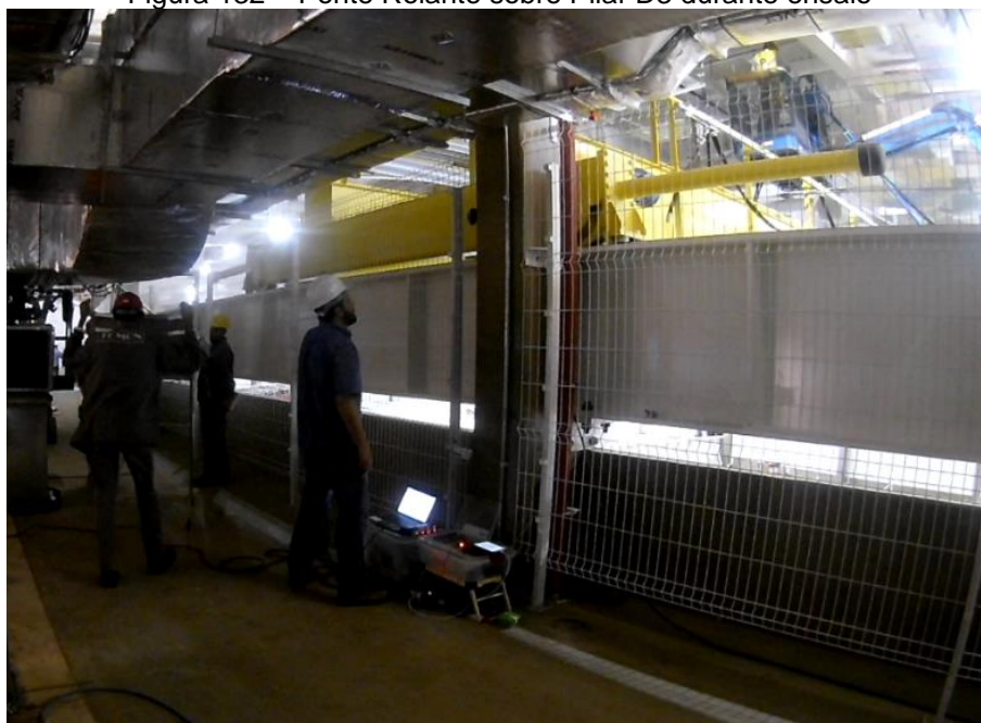
Figura 132 – Ponte Rolante sobre Pilar D3 durante ensaio
