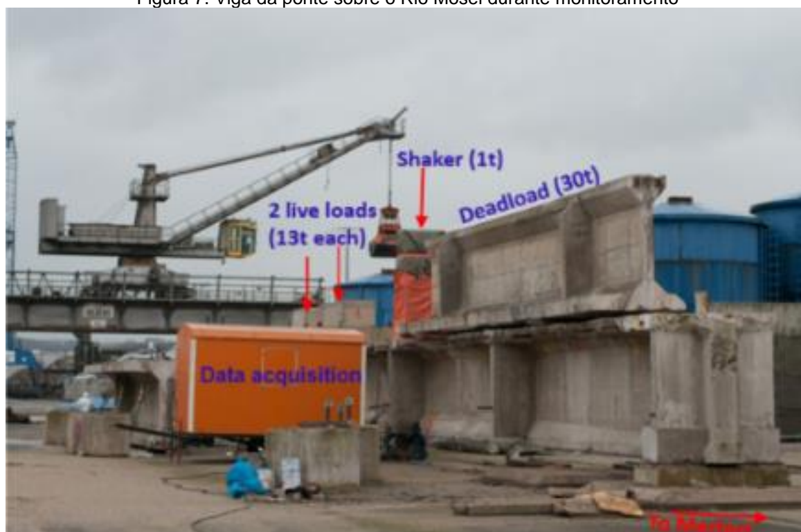
Figura 7. Viga da ponte sobre o Rio Mosel durante monitoramento
