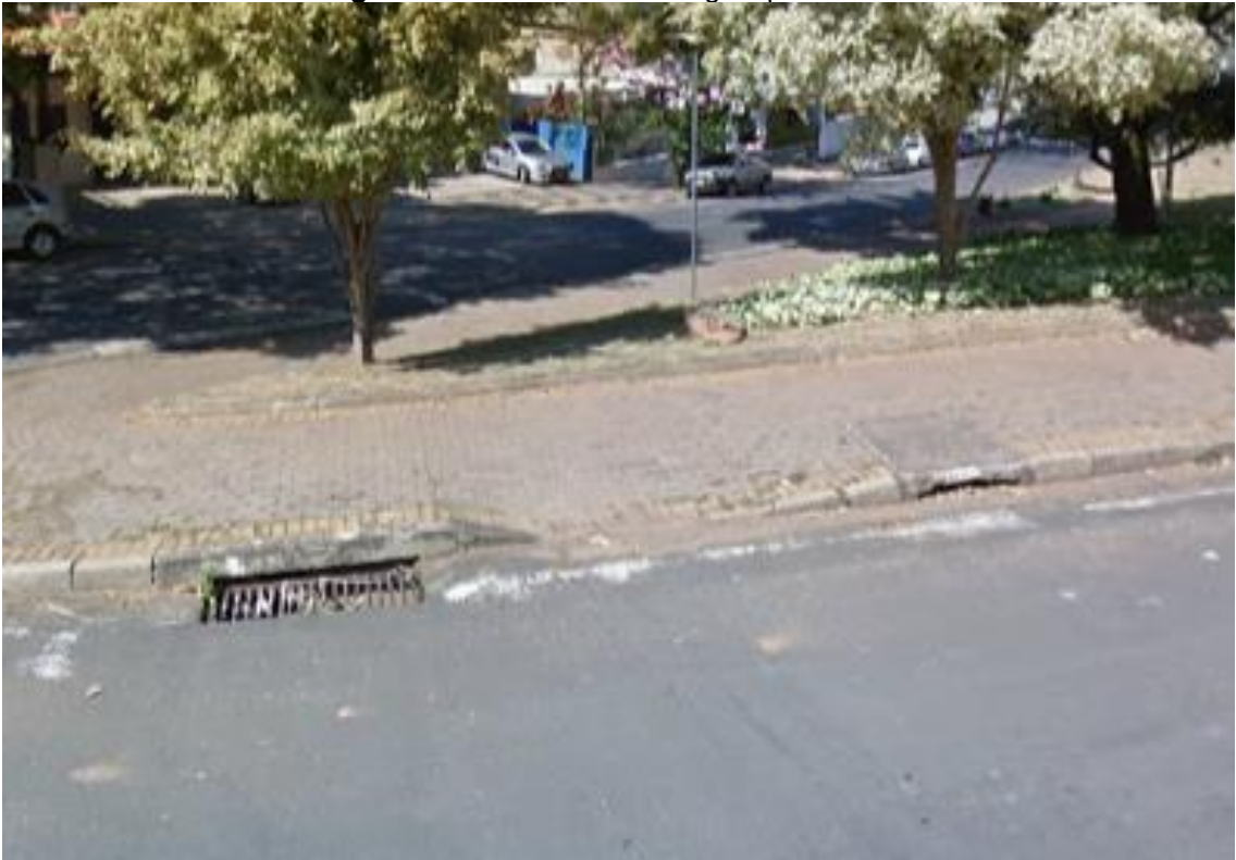
Figura 26. Rebaixamento da guia para acessibilidade
