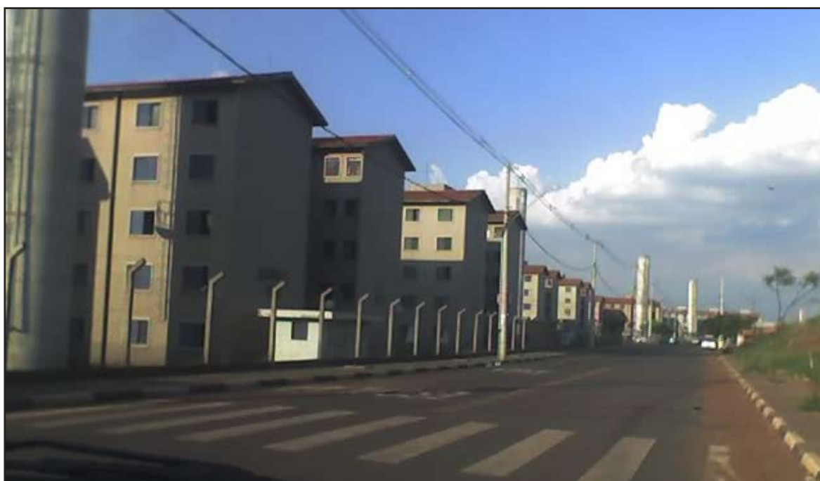
Fig. 40: Vista Edifícios CDHU E.
