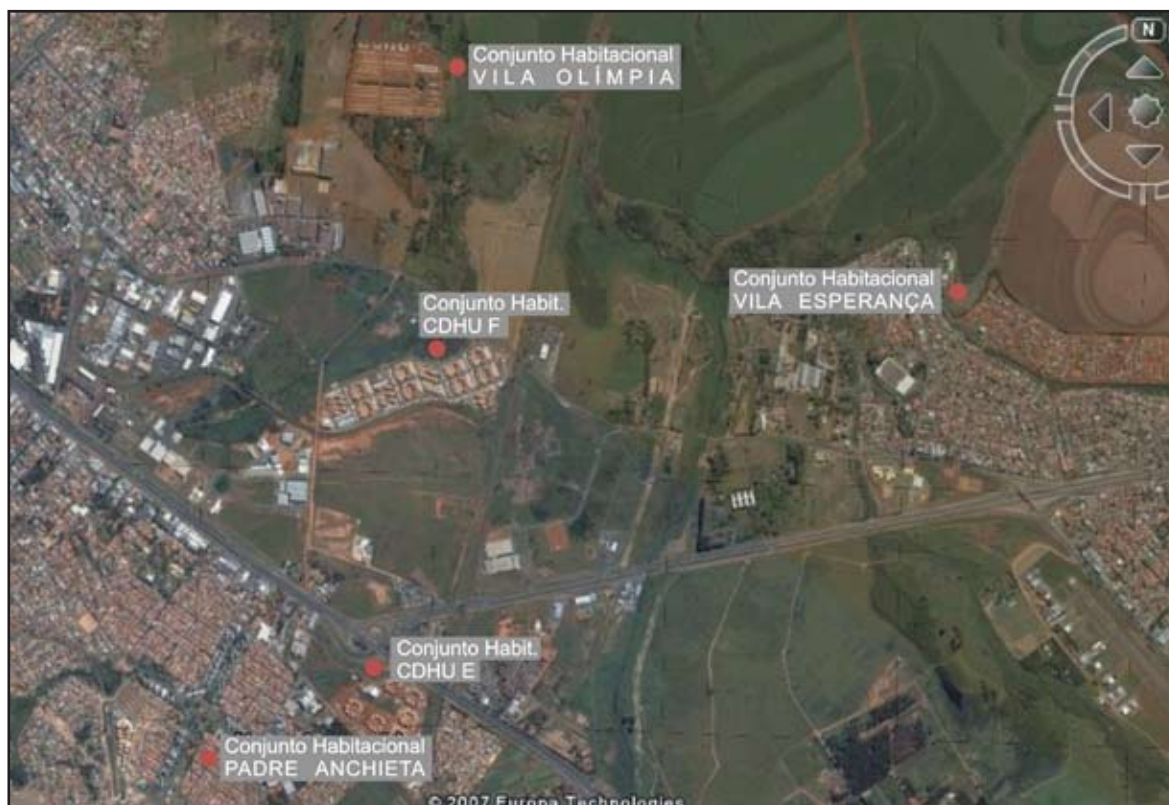
Fig. 12: Vista aérea dos conjuntos habitacionais analisados.
