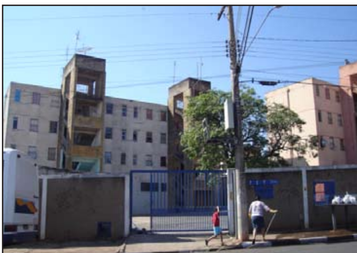
Fig. 36: Edifício de Apartamentos. Foto: Raquel Alves (2006).
