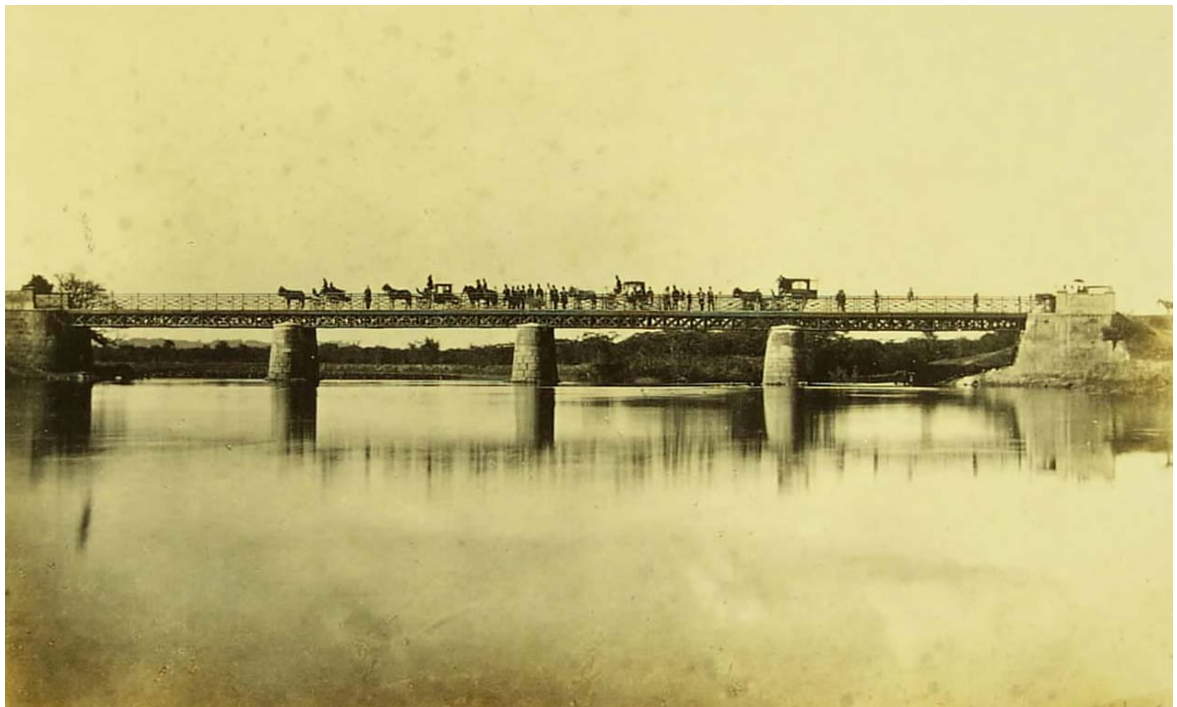
Figura 16: O Caminho da Luz em direção a Minas Gerais atravessava o Rio Tiete pela ponte de Sta. Anna fotografada por Militão em 1862.
