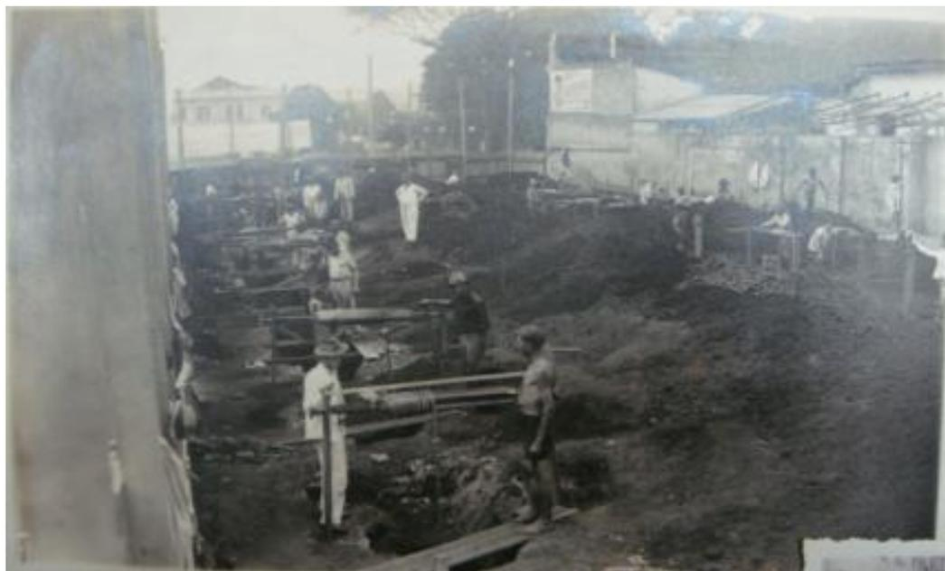
Figura 31. Detalhe da perfuração dos poços. Data: 22 de setembro de 1934. Fonte: Albúns Edifício Diederichsen.
