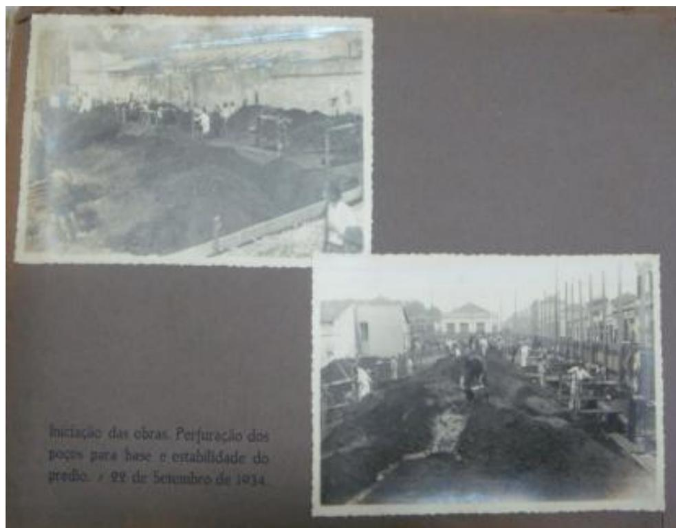
Figura 30. Fotos do início das obras, no dia 22 de setembro de 1934. “Perfuração dos poços para base e estabilidade do prédio. Fonte: Albúm do Edifício Diederichsen.
