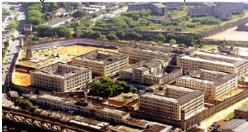
Figura 13. Vista aérea com todos os pavilhões
