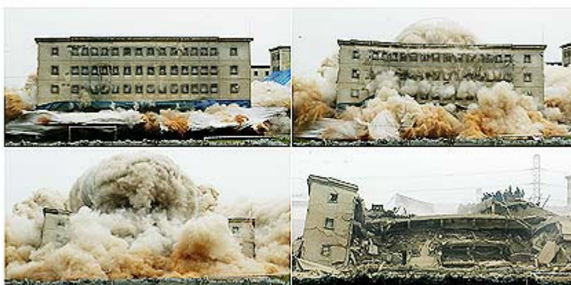
Figura 18. Implosão dos prédios do Carandiru
