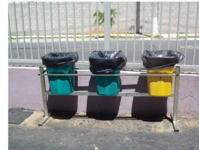
Lixeiras instaladas (Cond. C3)
