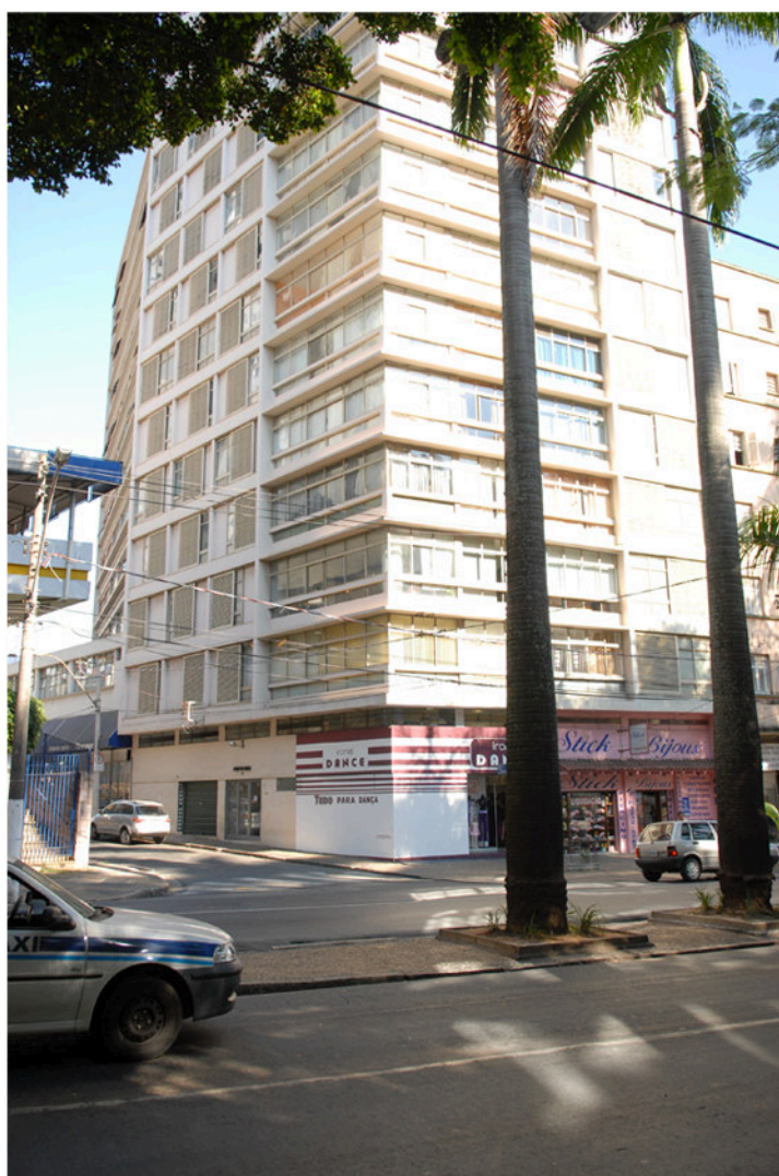
Fig. 25 - Fachadas do Edifício Roque de Marco, voltadas para a Avenida Irmã Serafina e Rua Cesar Bierrembach. Fonte: Foto do autor.
