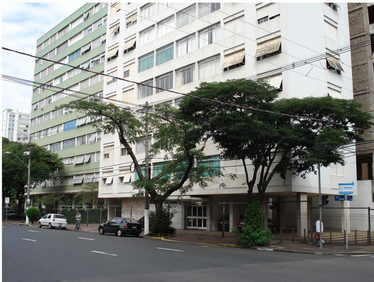
Fig. 67 - Edifício Veneza em primeiro plano. Fonte: Foto do autor.
