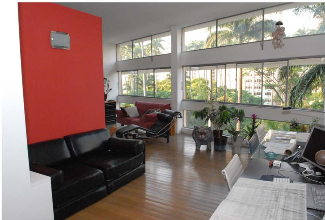
Fig. 126 - Vista do interior do apartamento situado no 5º andar, mostrando teto sem vigas, inclusive sobre as janelas que se abrem para o Jardim Carlos Gomes resultado do uso da laje caixão perdido. A fachada é dividida em três alturas que compreendem o peitoril, as janelas de correr com sistema de abertura que facilita a limpeza da face externa e a bandeira. As esquadrias são de cantoneiras de ferro, o que confere leveza ao conjunto. Fonte: Foto do autor - 2008.
