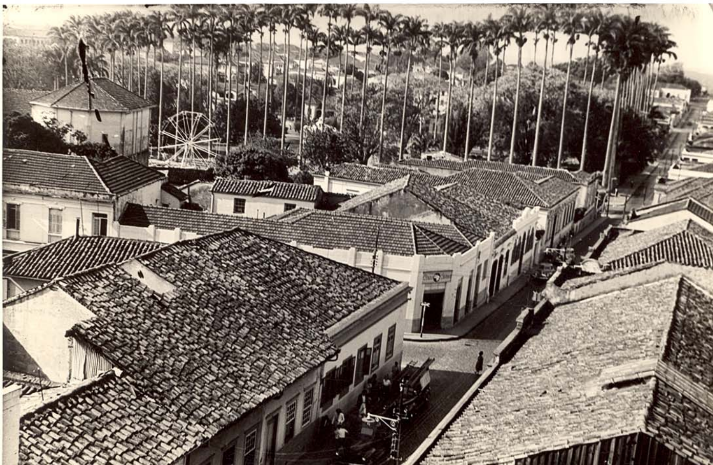
Fig. 116 - Rua Conceição, Jardim Carlos Gomes e no canto esquerdo, ao alto, o Cine Coliseu, cujo terreno foi canteiro de obras do Itatiaia, e em seguida recebeu o Clube Semanal de Cultura Artística. Fonte: Coleção GB 0232 - Acervo Museu da Imagem e do Som de Campinas.
