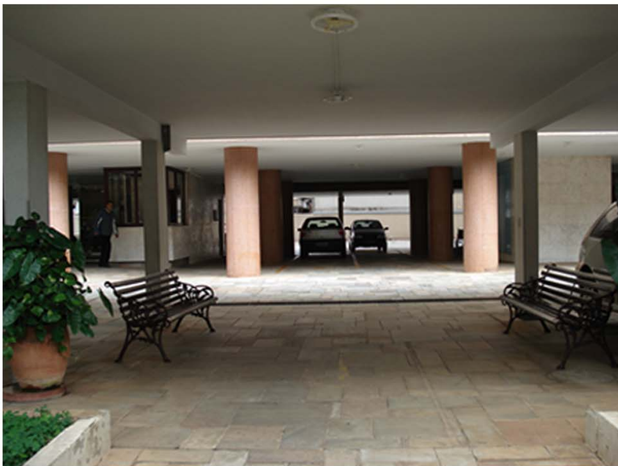
Fig. 54 - O Piauí-Maranhão hoje com bancos de madeira sob marquise acrescentada posteriormente. Os pilares são revestidos com pastilhas cerâmicas. Fonte: Foto do autor - 2008.
