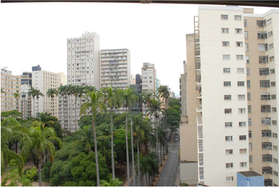
Fig. 91 – Lateral do Edifício Itatiaia vista a partir do interior do 7º andar do Edifício Roque de Marco. Fonte: Foto do autor – 2009.
