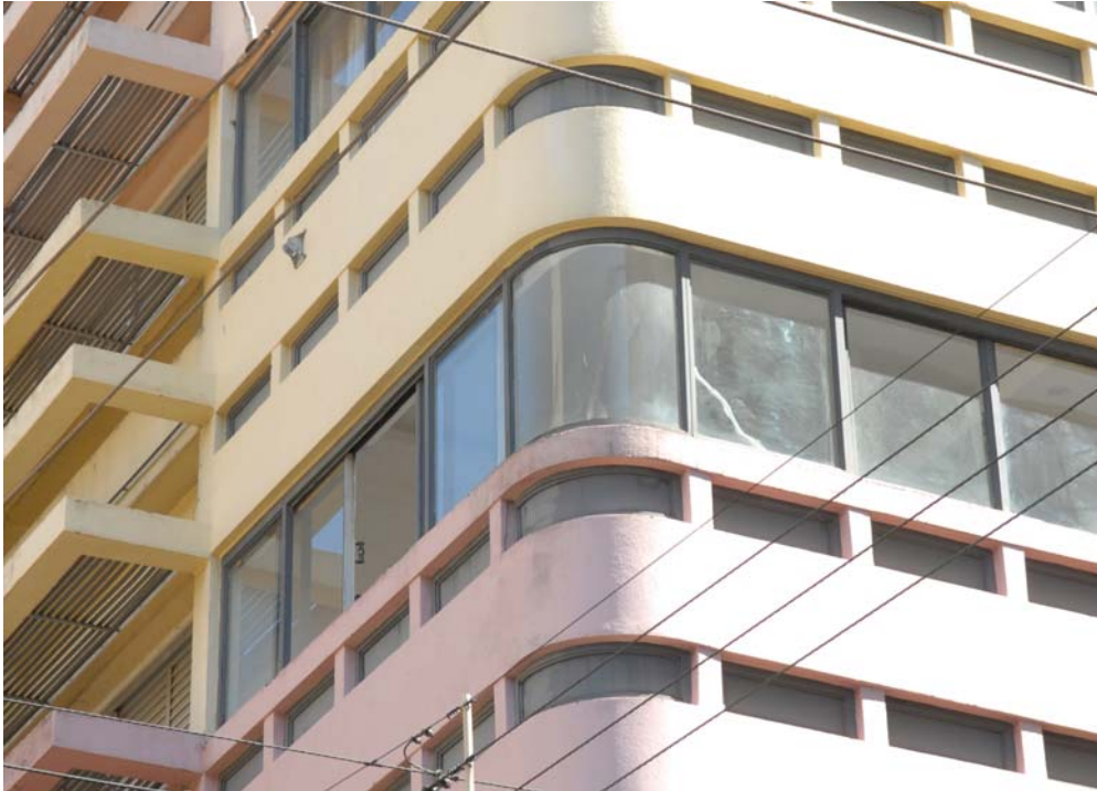
Fig. 18 – Edifício Lunardi. - os vidros curvos foram feitos especialmente para esta obra. Fonte: Foto do autor - 2008.
