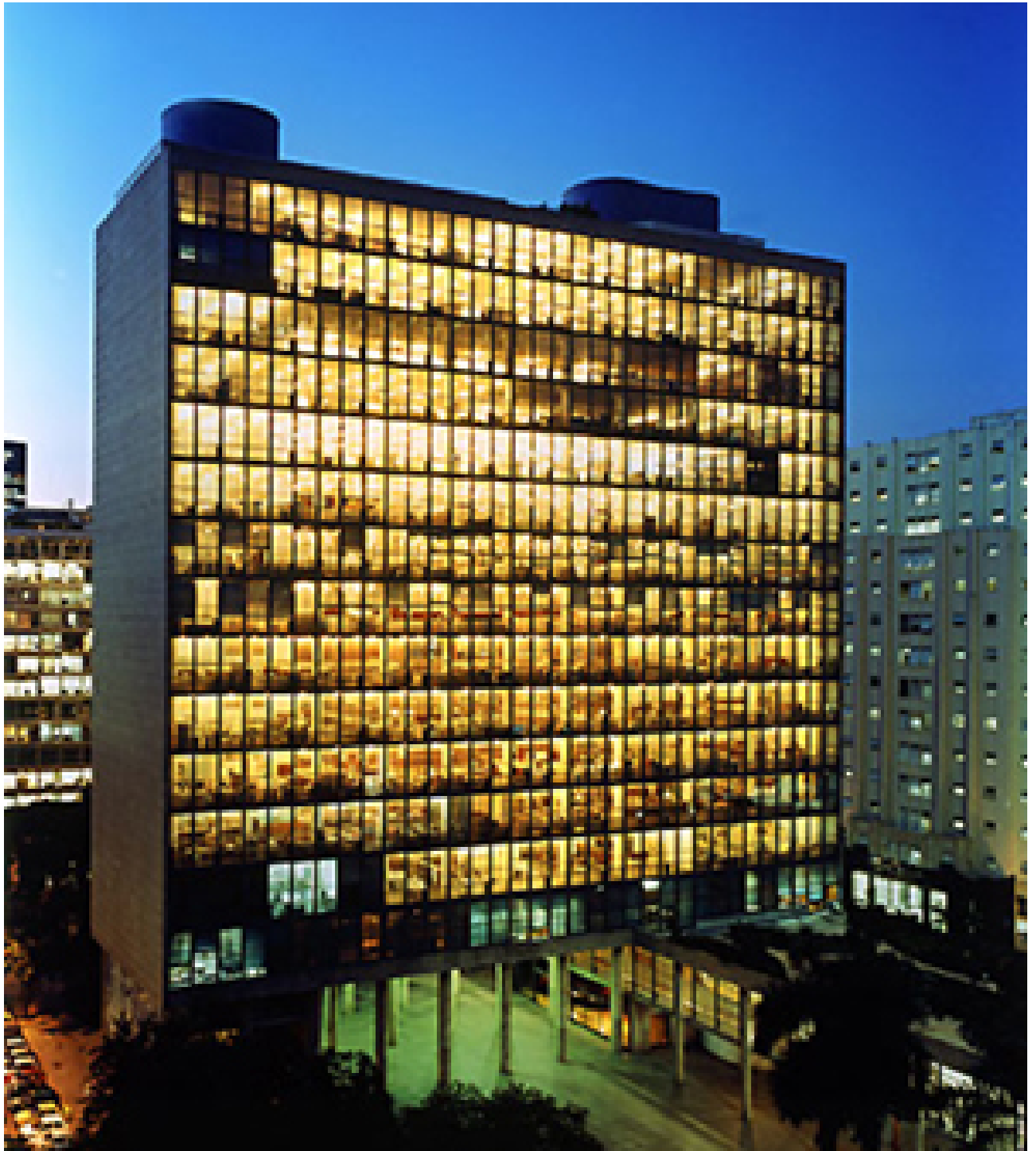
Fig. 81 – Ministério – fachada sudeste pondo em evidência as lajes planas sem viga e a continuidade dos pilotis por todos os pavimentos. Fonte: Recamán, 2004: 115.
