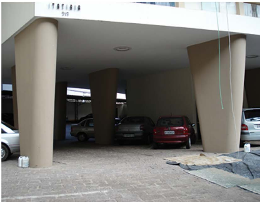
Fig. 122 - Pilares em “V” e laje plana do teto do térreo. Fonte: Foto do autor - 2008.
