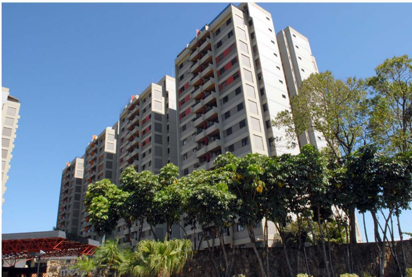
Fig. 39 - Fachada do Residencial Cidades do México, vista da Avenida Nossa Senhora de Fátima. Fonte: Foto do autor - 2008.
