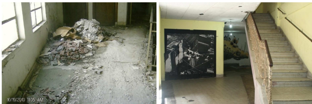
Figura 25: Hall em um dos andares da ocupação (antes e depois). Fonte: Mildo Ferreira.
