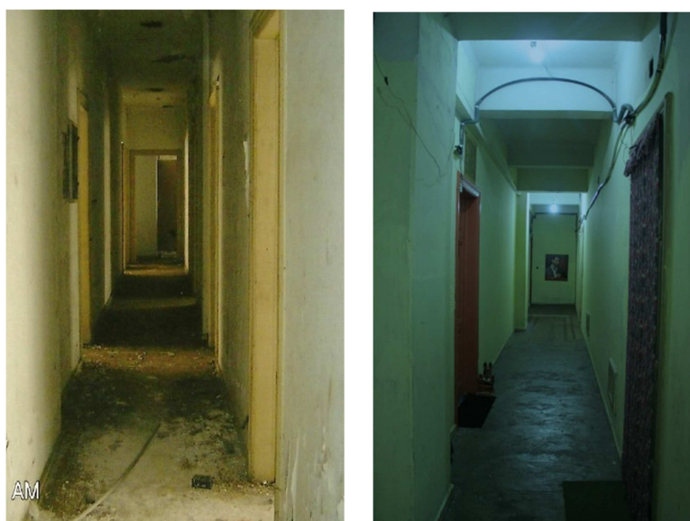
Figura 26: Corredores dos quartos em um dos andares da ocupação (antes e depois). Fonte: Mildo Ferreira.
