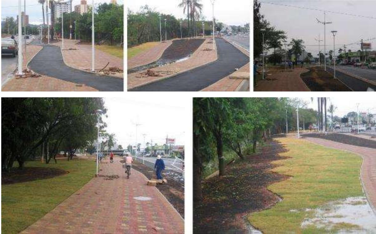
Figura 87: Fotos das obras de colocação do piso intertravado nas pistas de caminhada, pavimentação asfáltica na ciclovia e colocação da grama demarcando as áreas para execução do paisagismo ornamental.
