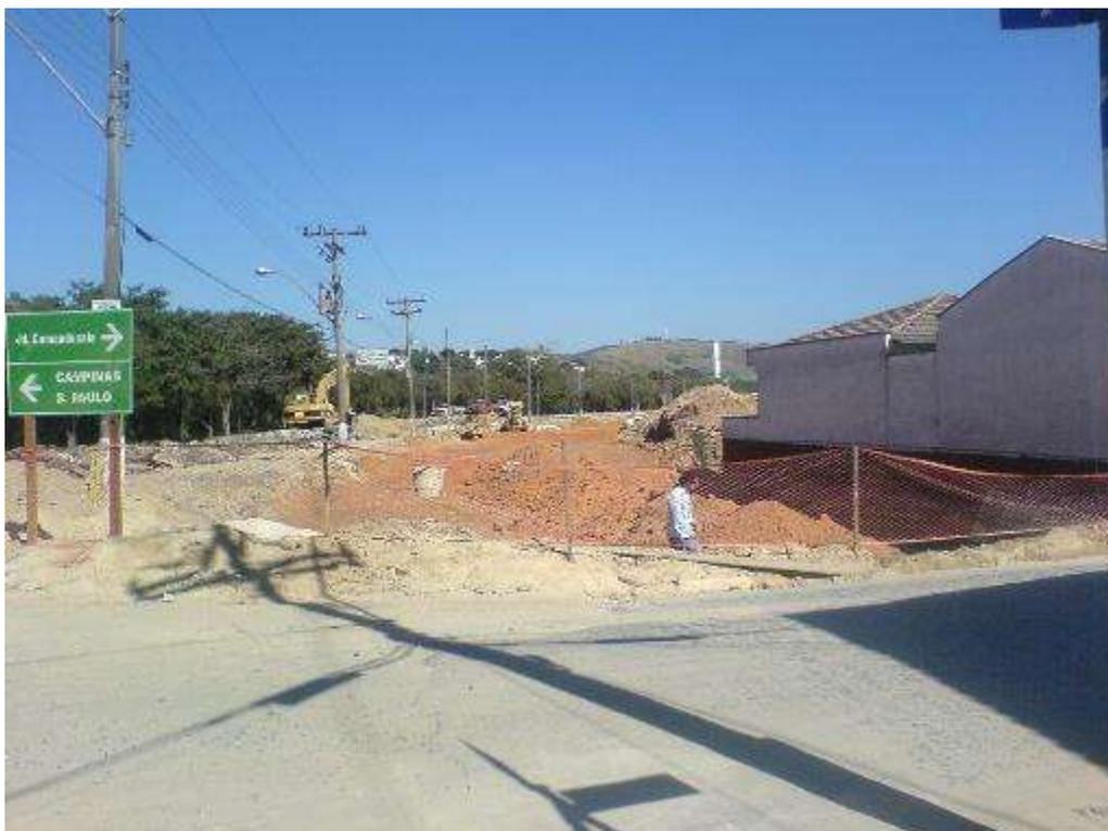
Figura 83: Foto das obras de demolição para a duplicação da avenida Doutor Carlos Burgos. Demolição da pista existente.
