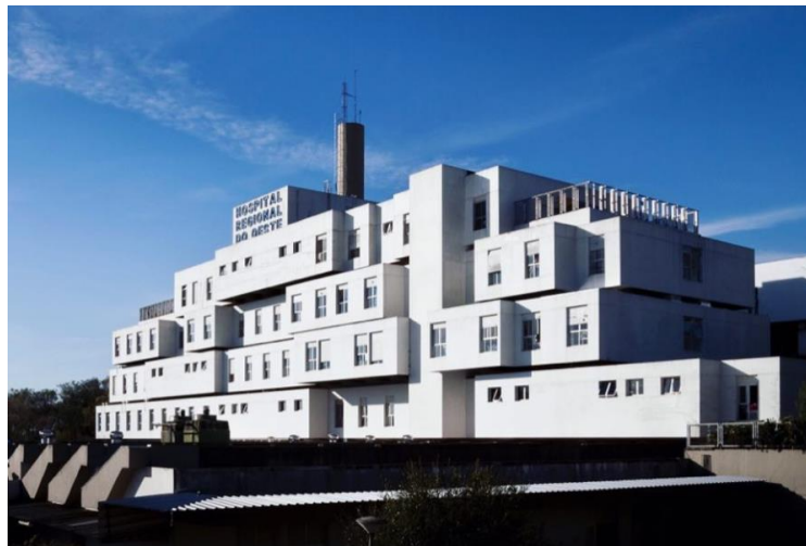
Figura 18 - Fachada Oeste do Hospital Regional de Cahpecó, destacando o jogo de volumetria imposto pela malha utilizada por Irineu Breitman na torre de internação.
