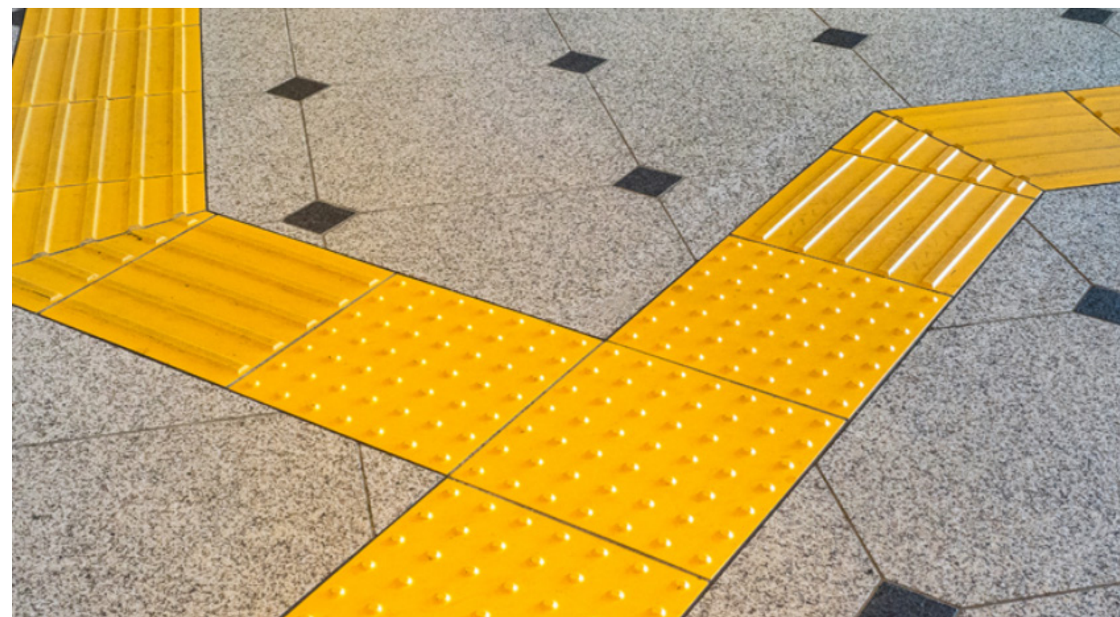
Figura 3 Diferentes tipos de sinalização tátil de alerta e direcional Fonte: WAT Qualidade Acessível, 2019, on-line
