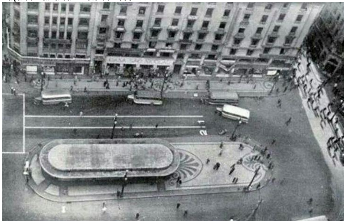
Figura 20. Cobertura projetada por Elisário Bahiana na entrada da galeria Prestes Maia na Praça do Patriarca – Foto de 1939
