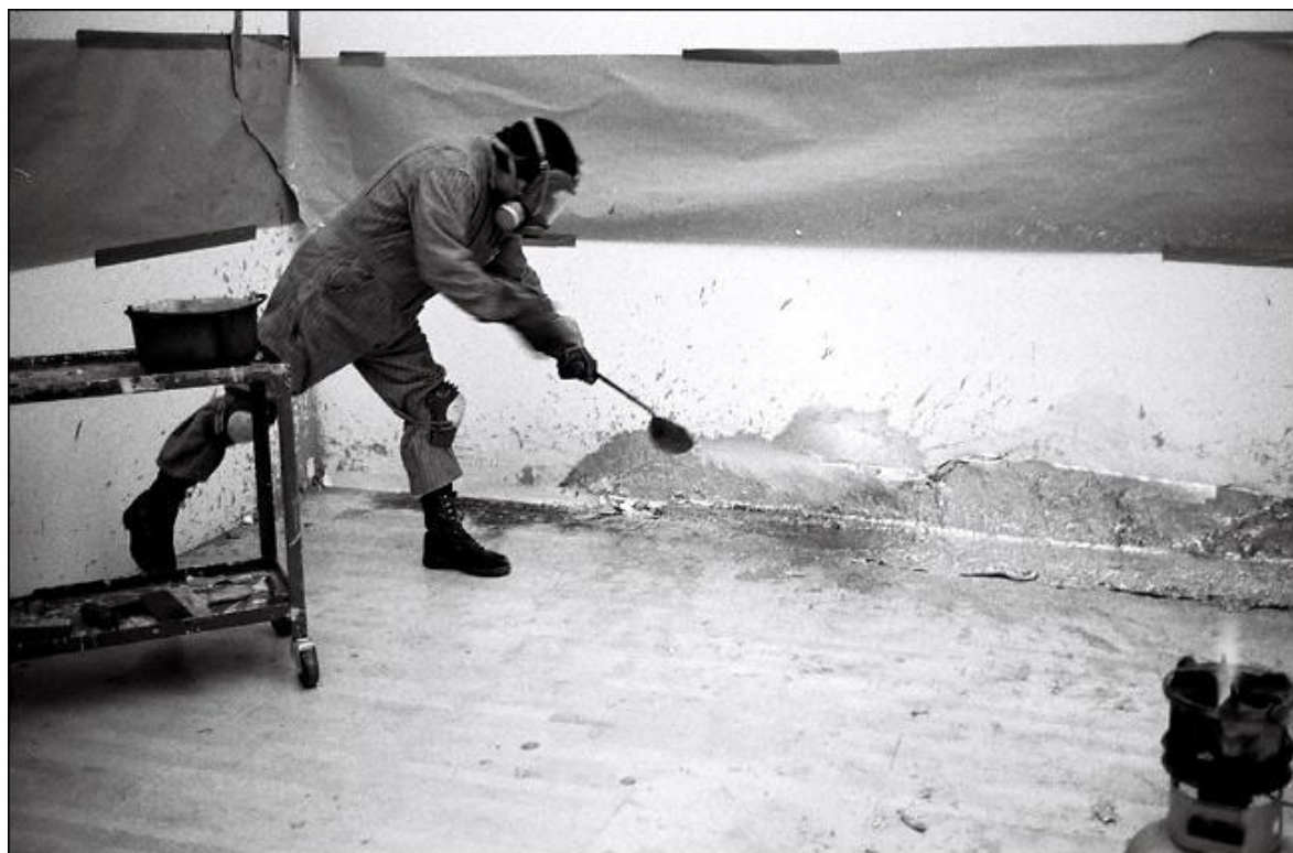
Figura 2. Richard Serra durante a instalação de sua obra “ Gutter Corner Splash – Night Shift ” – 1969 - Chumbo derretido jogado em piso e parede
