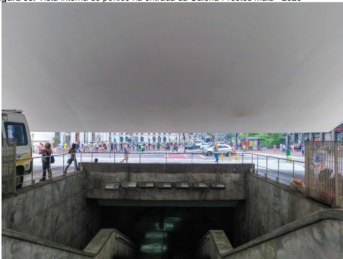
Figura 33. Vista interna do p3rtico na entrada da Galeria Prestes Maia - 2020
