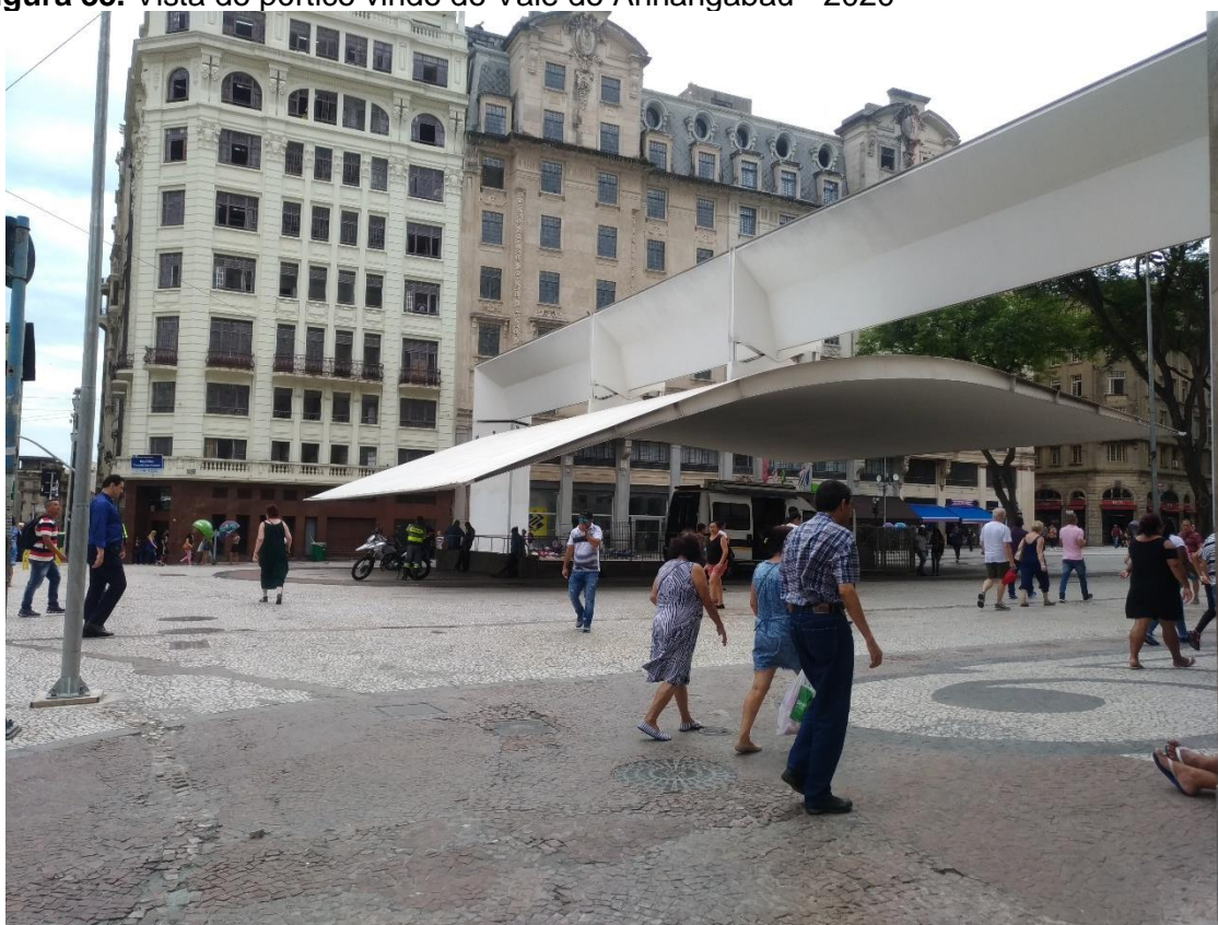
Figura 35. Vista do pórtico vindo do Vale do Anhangabaú - 2020
