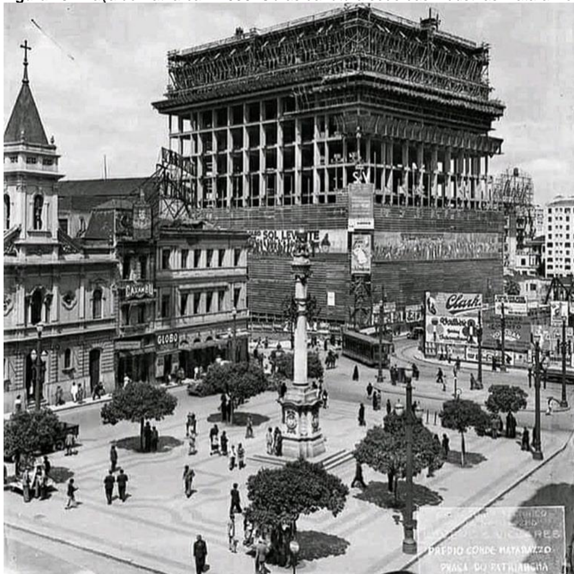
Figura 18. Praça do Patriarca – 1936: Obras da futura sede das Indústrias Matarazzo.
