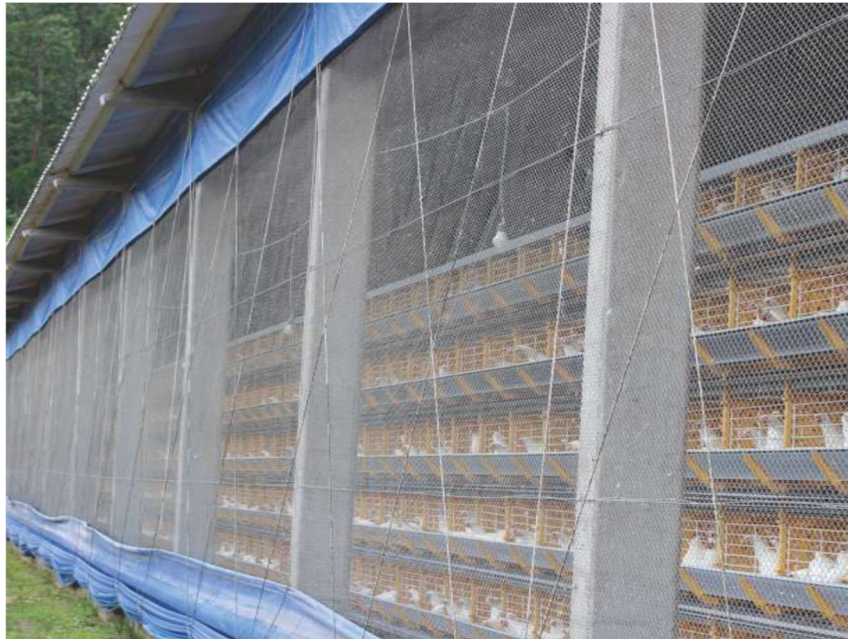
Figura 3: Fotografia da lateral do galpão evidenciando a malha de uma polegada nas laterais dos galpões.
