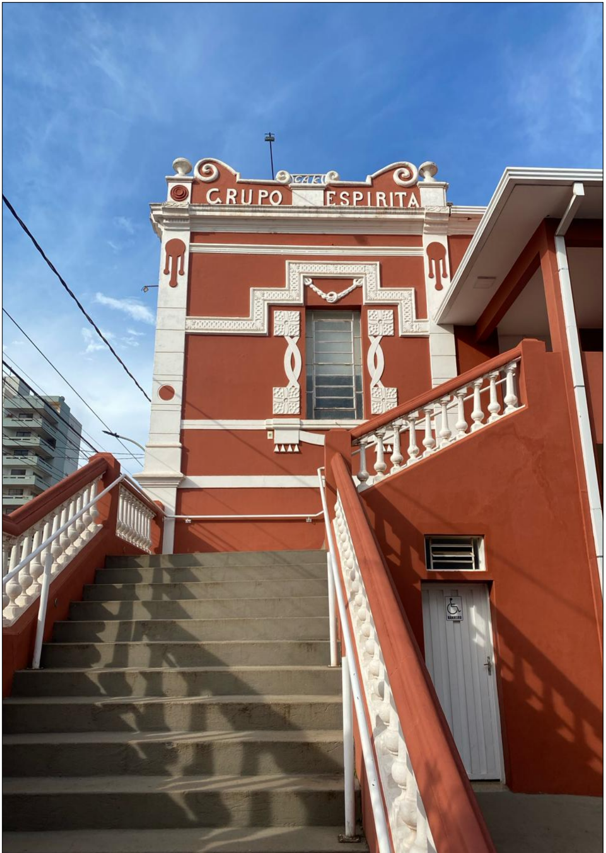
Figura 8: Fotografia das escadarias do edifício que abrigava o antigo colégio Allan Kardec, em Sacramento (MG). Fonte: Do autor, 2024.
