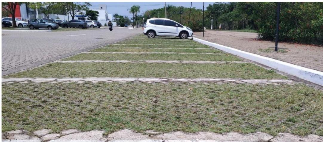
Figura 146 - Exemplo de aplicação de piso permeável de concregrama em estacionamento de veículos e piso de blocos de concreto intertravados em calçadas e leito carroçável. Foto autoral: Milena Boni. Fonte: São Paulo, 2024, p. 101.
