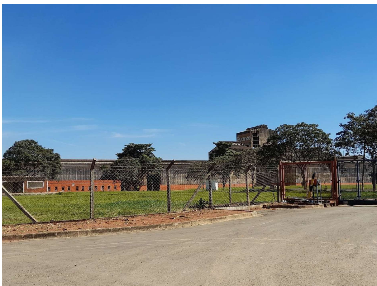
Figura 114- Galpão industrial - Guainco II, na Sp 340 Fonte: Foto autoral, 2024.
