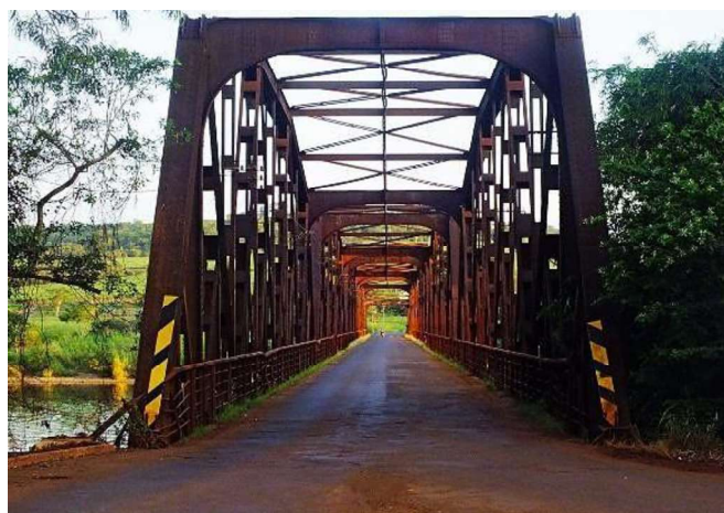
Figura 32 - Ponte rodoferroviária sobre o Rio Grande erguida em 1915 pela Companhia Mogiana de Estradas de Ferro. Foi usada pela ferrovia até 1979 e como ligação rodoviária entre a BR-050 e a SP-330 até 2001.
