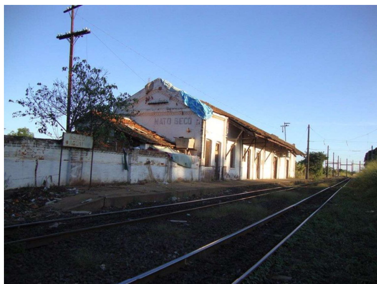
Figura 36 - A estação Mato Seco em 2015 Fonte: Estações ferroviárias do Brasil. Foto de Luiz Fernando Pecchiore Bastos.
