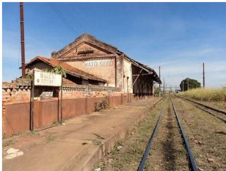
Figura 35 – Estação da Mogiana Mato Seco, em Mogi Guaçu, 2011 Fonte: Estações ferroviárias do Brasil
