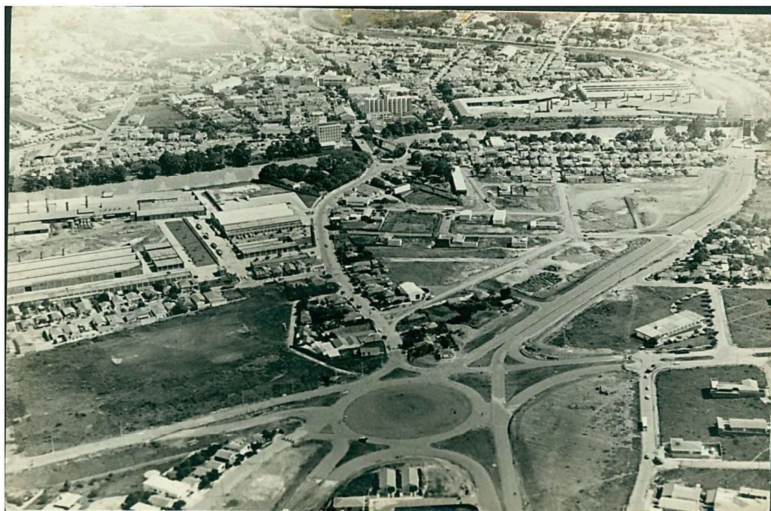
Figura 127 - Paisagem de Mogi Guaçu no século XX – Cerâmica São José à esquerda, e Cerâmica Mogi Guaçu à direita
