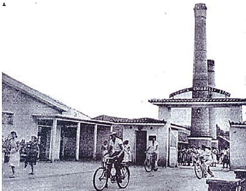
Figura 104 – fachada da Cerâmica Chiarelli, unidade I Fonte: Gazeta Guaçuana, 2024.
