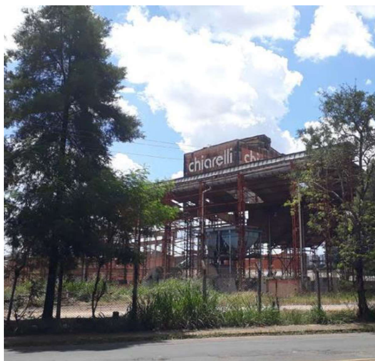
Figura 110 - Antigo edifício Cerâmica Chiarelli
