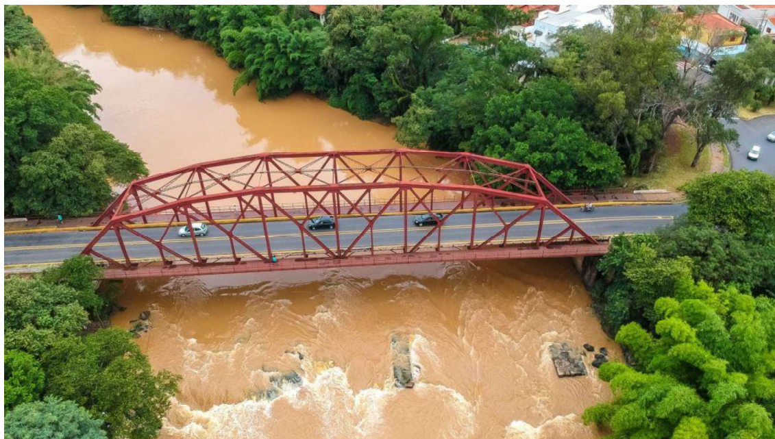
Figura 5 – Ponte de ferro sobre o rio Mogi Guaçu, no município homônimo Fonte: Cataguá Construtora.
