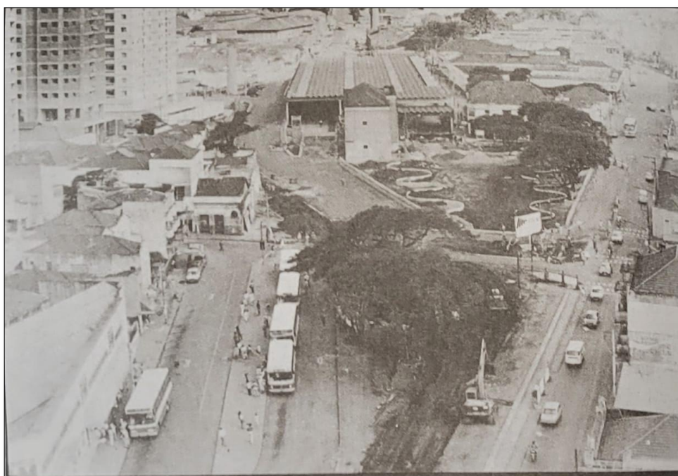
Figura 18. Obra do Terminal Central de Integração.
