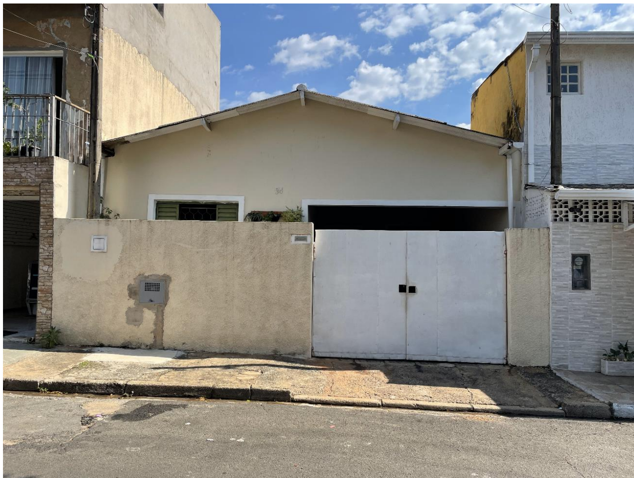
Figura 53: Fotografia de uma das casas da Rua Julian Brice Mac Fadden, Favela Cafezinho, Campinas, que mantém a morfologia original, em duas águas, conforme projeto do prefeito Toninho. Fonte: autoral. Data: 16 fev. 2024.
