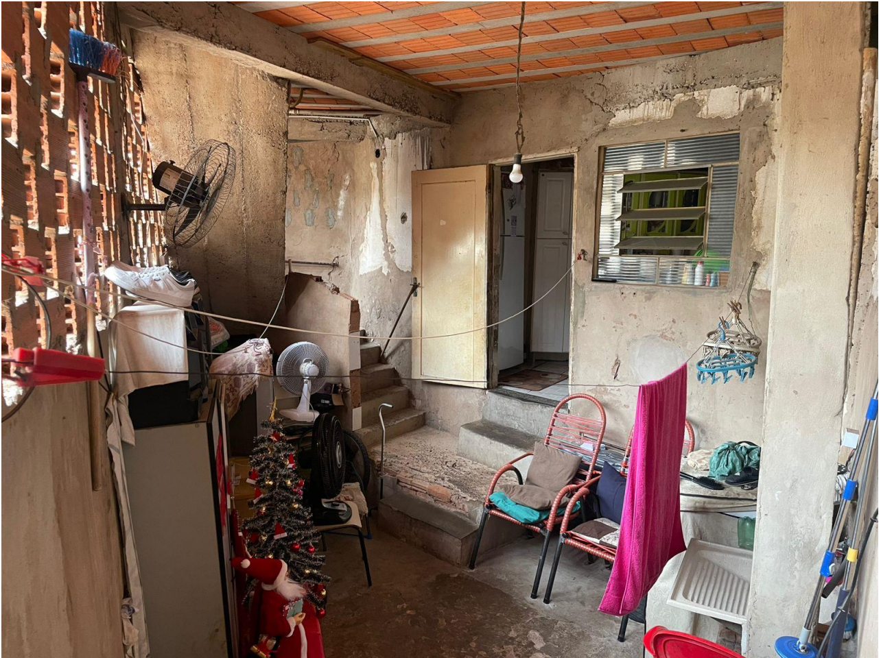
Figura 38: Fotografia da área de serviço, realizada desde a entrada pelo corredor, registrada pelo olhar de Catarina. Fonte: Catarina (moradora entrevistada, nome fictício), 08 dez. 2024.
