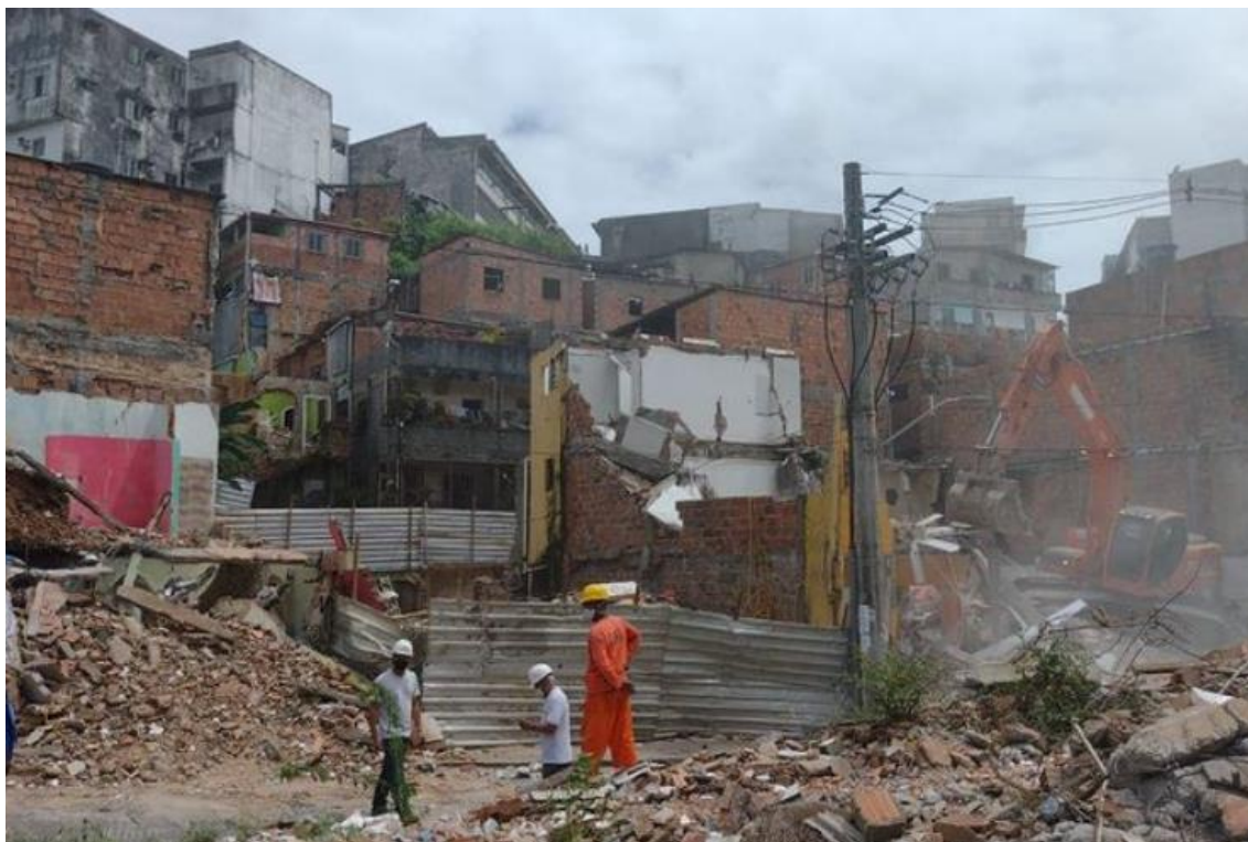
Figura 32 – Demolições na Rua Monsenhor Rubens Mesquita, outubro de 2021.
