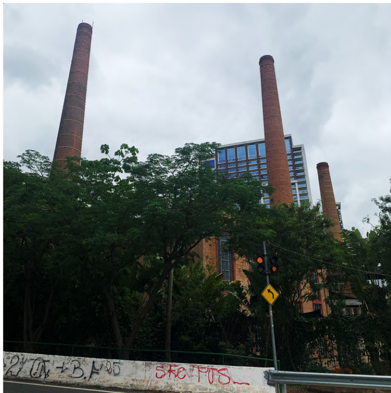
casa das caldeiras, fachada frontal
