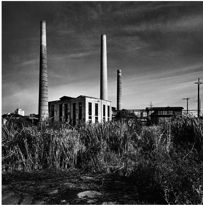
complexo matarazzo, casa das caldeiras
