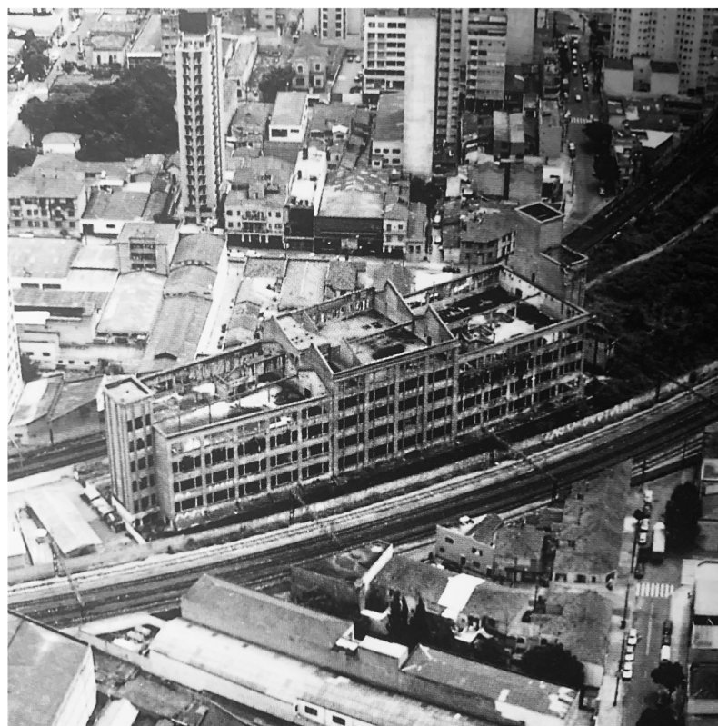
moinho central, edifício
