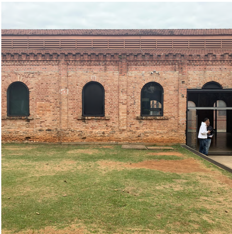
cinemateca brasileira, fachada lateral
