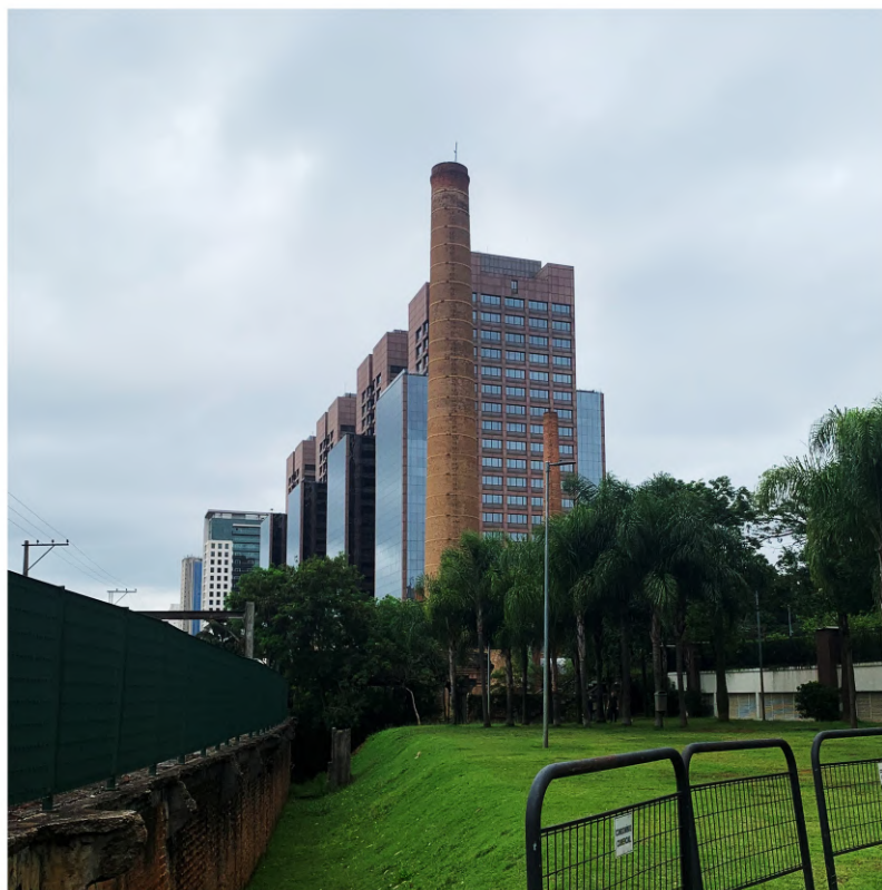
casa das caldeiras, fachada posterior
