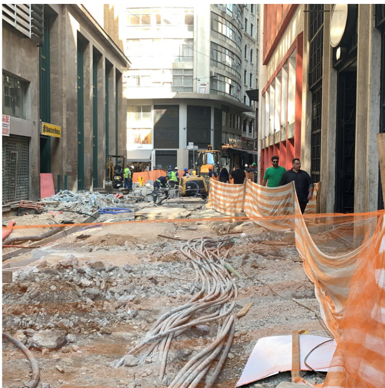
centro de são paulo, obras
