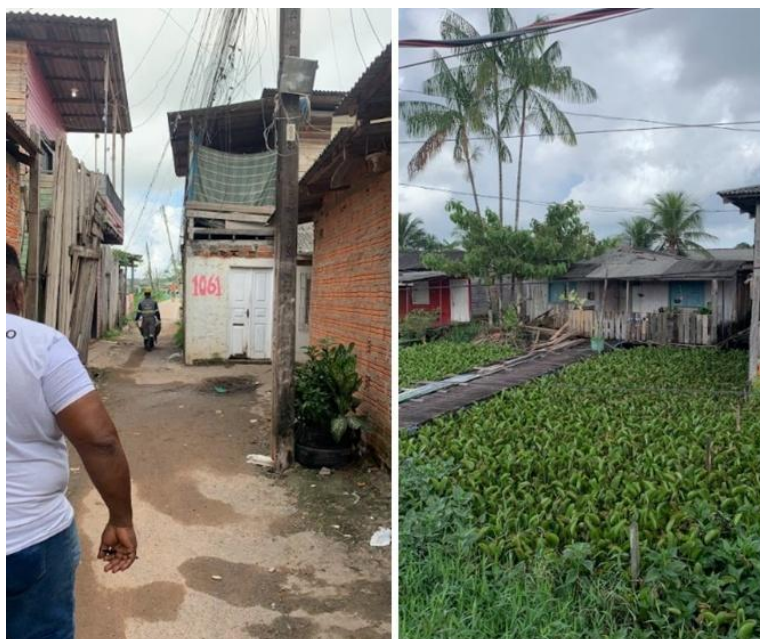
Figura 73 - Esquerda- Casas próximas ao nível da rua na transição da terra firme para a Passarela 20ª da ressaca Congós. Direita - Cota da passarela de madeira próxima a água sob plantas aquáticas
