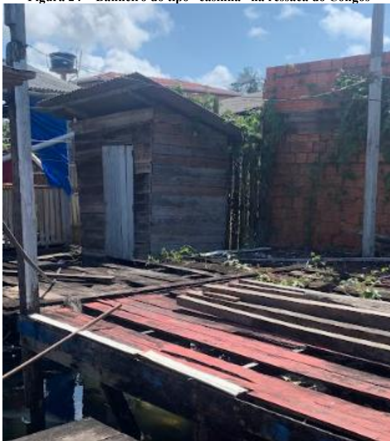
Figura 24 - Banheiro do tipo “casinha” na ressaca do Congós
