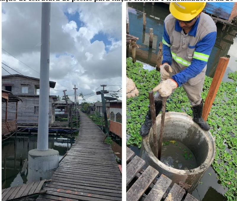
Figura 72 - Instalação de estrutura de postes para fiação elétrica e trabalhadores na 20ª da ressaca Congós
