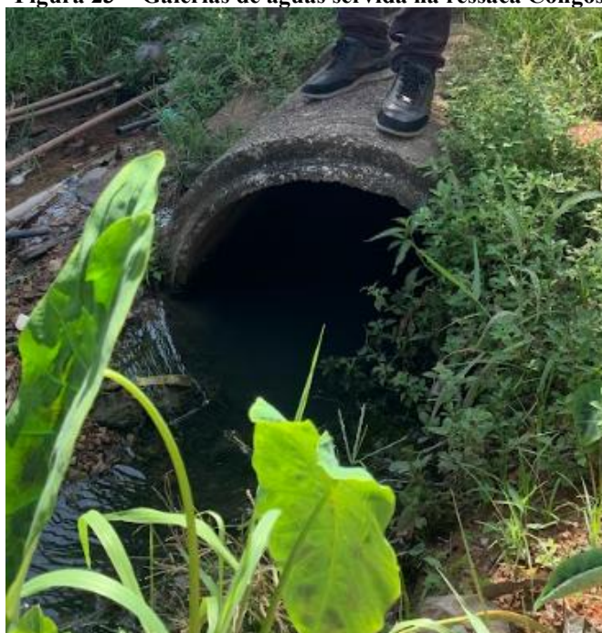
Figura 23 - Galerias de águas servida na ressaca Congós
