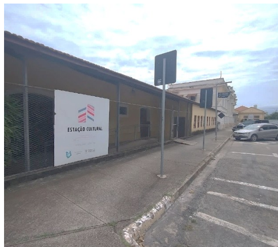
Figura 66: Rampa adaptada para o acesso ao Barracão Cultural, com a presença de obstáculos à frente. Foto: da autora, 2025.
