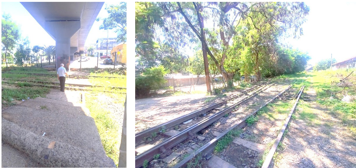
Figura 93: Passagens improvisadas por pedestres para transpor a linha férrea já desativada. Foto: da autora, 2025.
