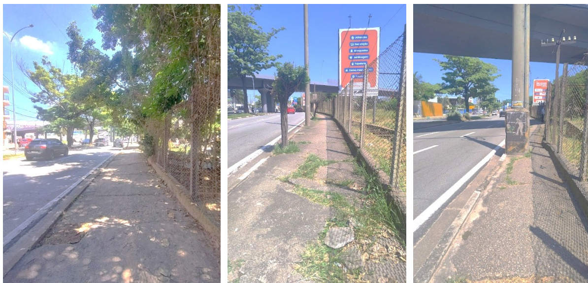
Figura 73: Da esquerda para a direita o caminho entre o Ponto 1 até o Ponto 3. Em todo o trajeto há piso irregular e obstáculos, sem possibilidade de travessia com segurança para o outro lado da via. Foto: da autora, 2025.
