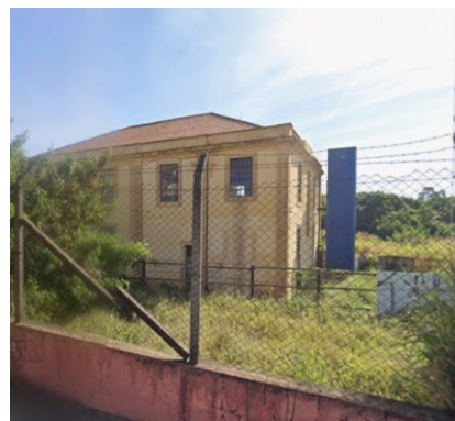
Figura 56: Anexo na parte posterior da edificação do MACS e elevador de acesso. Foto: da autora, 2025.
