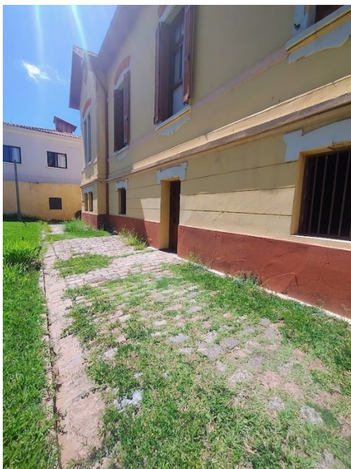
Figura 103: Corredor lateral de acesso ao subsolo do museu, onde se localizam os sanitários, a copa e o administrativo. Foto: da autora, 2025.
