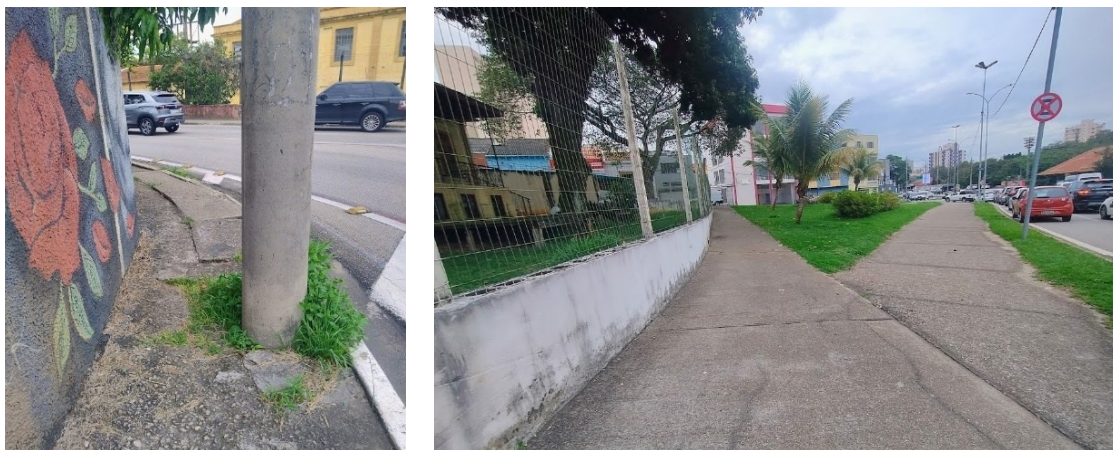
Figura 71: Situação do passeio público no entorno da praça Maylasky. À esquerda, há uma passagem estreita por causa de poste elétrico, bocas de lobo e vegetação. À direita é mostrado um local com o calçamento em bom estado e caminhos amplos. Foto: da autora, 2025.
