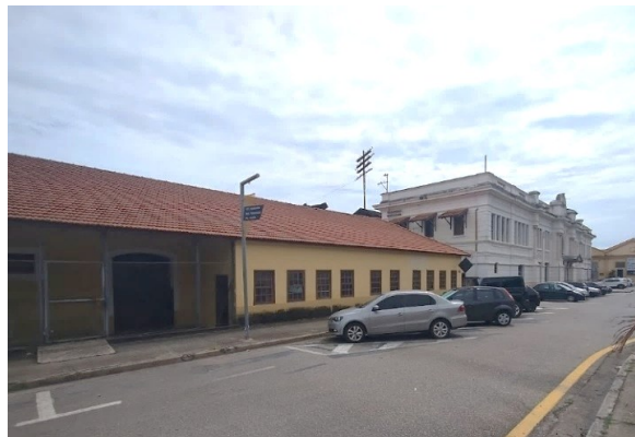
Figura 50: Edifício reformado para abrigar o Barracão Cultural. Foto: da autora, 2025.
