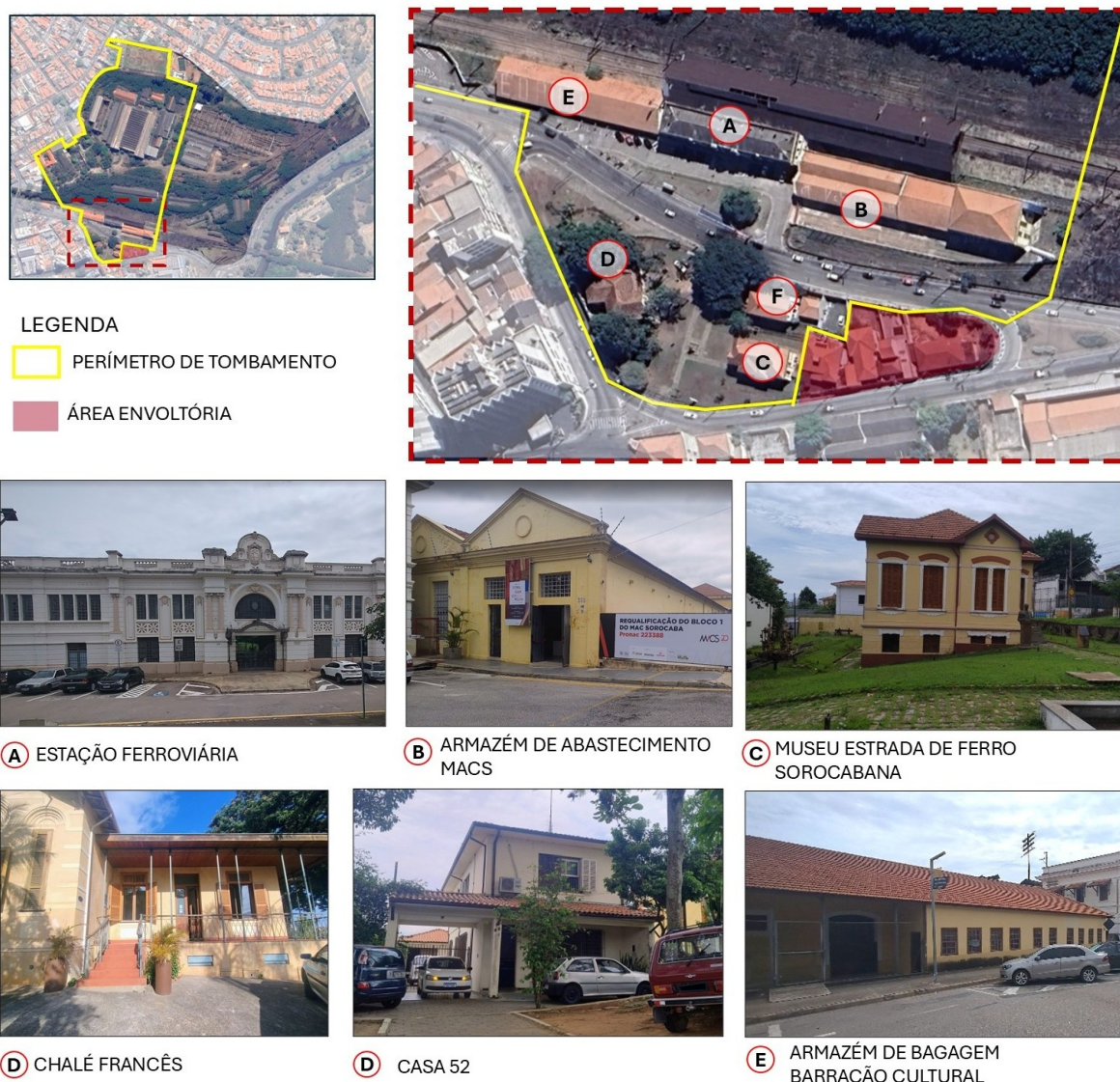
Figura 28: Detalhe da Estação e edificações do entorno, praça Maylasky e área envoltória tombada (tracejado vermelho – Fig. A-E).
