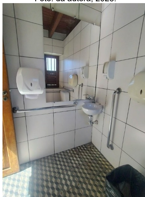
Figura 106: Interior do sanitário PNE, pia e barras de apoio. Foto: da autora, 2025.
