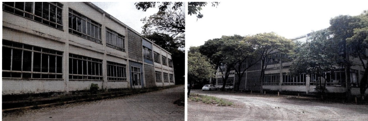
Figura 36: Fachadas da Superintendência em dezembro de 2014. Fonte: CONDEPHAAT, 2011, p. 257.
