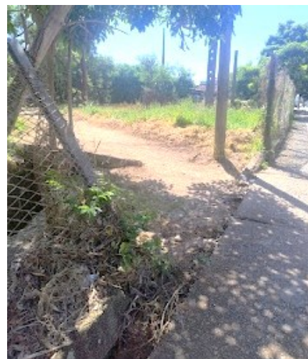
Figura 75: Travessia da linha férrea improvisada por pedestres com o rompimento da cerca. Foto: da autora, 2025.
