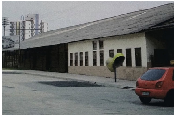
Figura 49: Foto do antigo Armazém de bagagens antes da primeira reforma. Fonte: Prefeitura de Sorocaba, 2013a.
