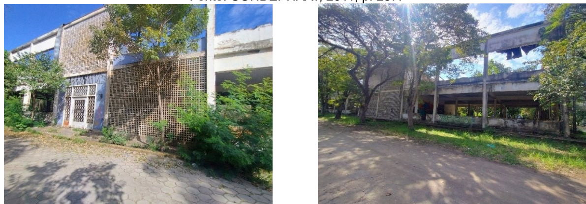
Figura 37: Fachadas da Superintendência em julho de 2025. Foto: da autora, 2025.
