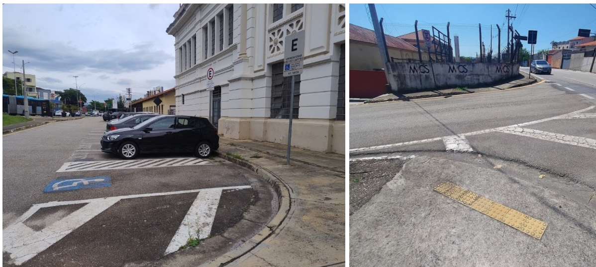
Figura 64: Vaga PNE em frente à Estação Ferroviária, sem rampa para acesso à calçada (à esquerda); rebaixamento da calçada com piso tátil de alerta, desassociado da faixa de pedestres (à direita).
