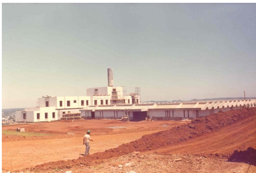
Figura 37 - Construção do Hospital Regional do Oeste em Chapecó, fachada Sul Fonte: CEOM, 2023
