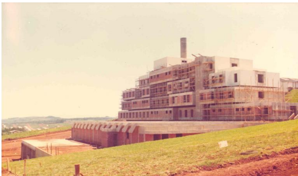
Figura 38 - Construção do Hospital Regional do Oeste em Chapecó, fachada Leste Fonte: CEOM, 2023
