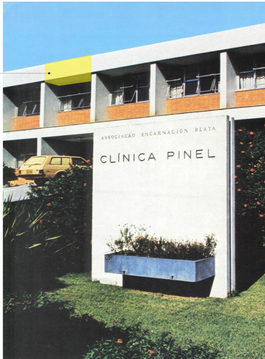
Figura 30 - Uso de brise horizontal para composição de fachada e controle luminoso na CP Fonte: Editado pela autora com base em Acervo Irineu Breitman – IPH, 2024
