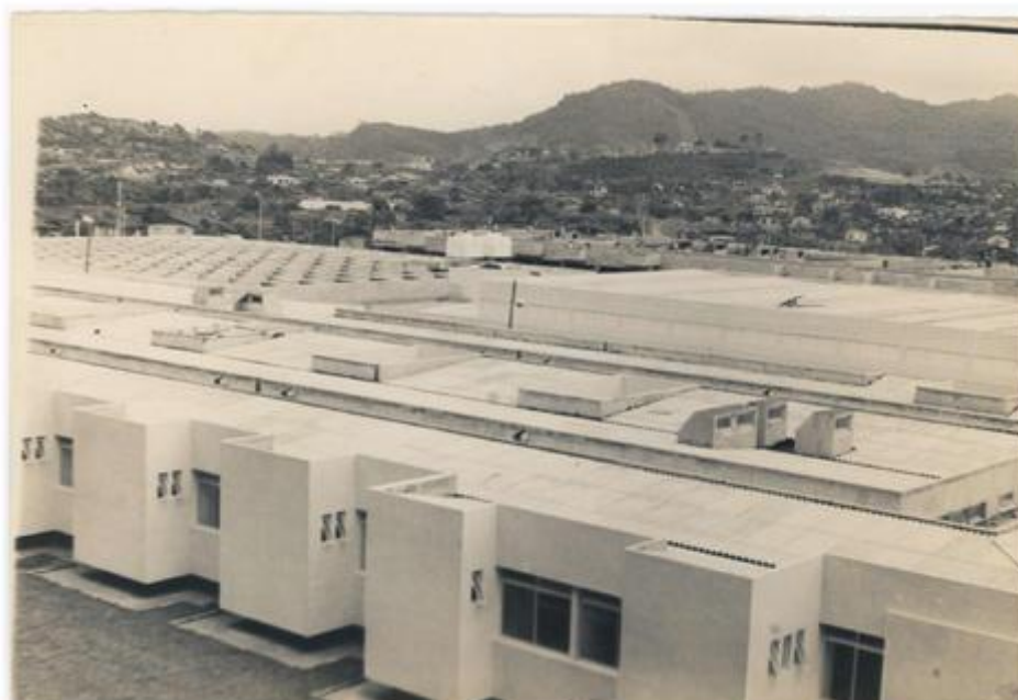
Figura 86 - Fachada do bloco de internação sul do HRHDS com destaque as esquadrias Fonte: CEOM, 2023
