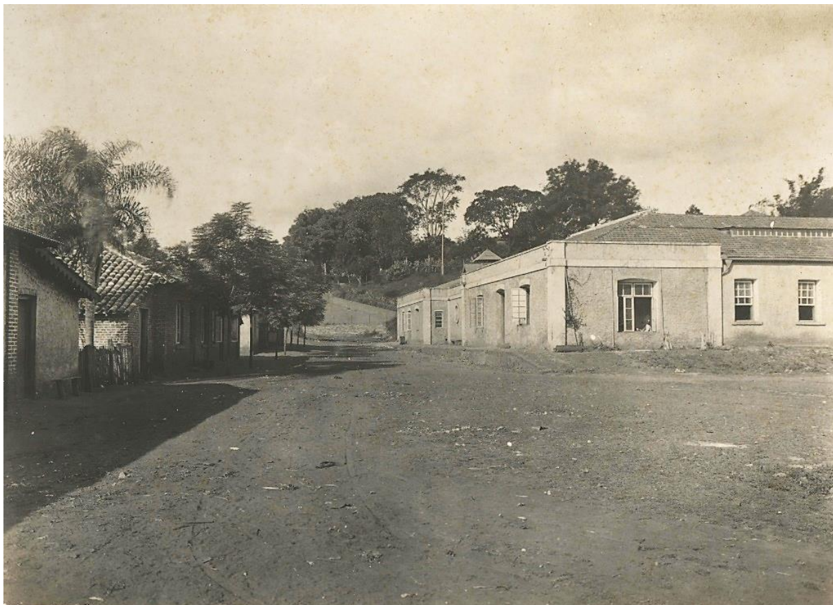
Figura 27. Vista da Vila Operária. (s/d)
