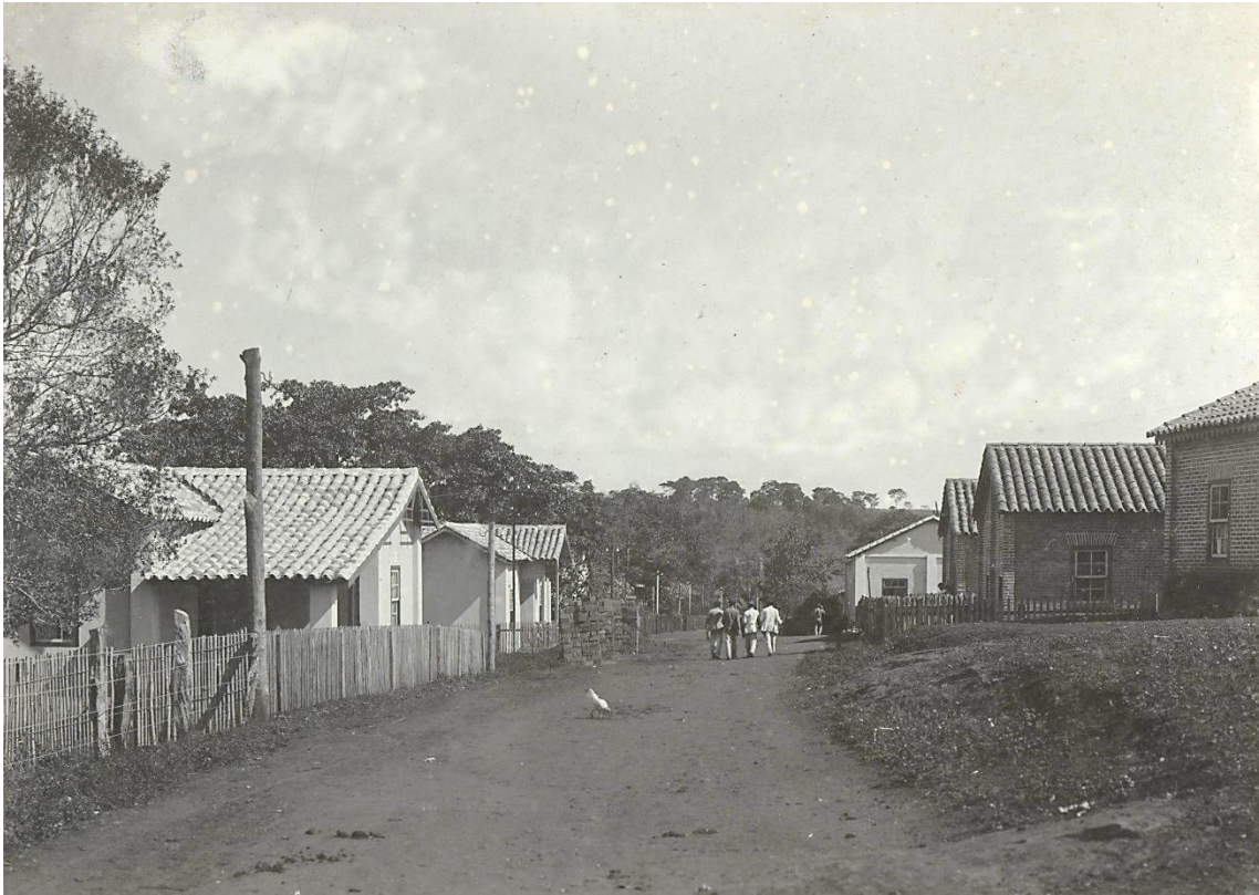
Figura 38. Vista da Vila Operária. s/d
