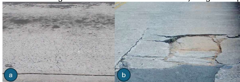
Figura 9: Defeitos diversos sem grau de severidade determinado - a) desgaste superficial; b) buraco
