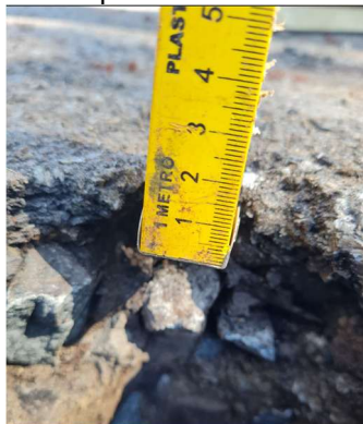
Figura 18: Espessura camada de asfalto
