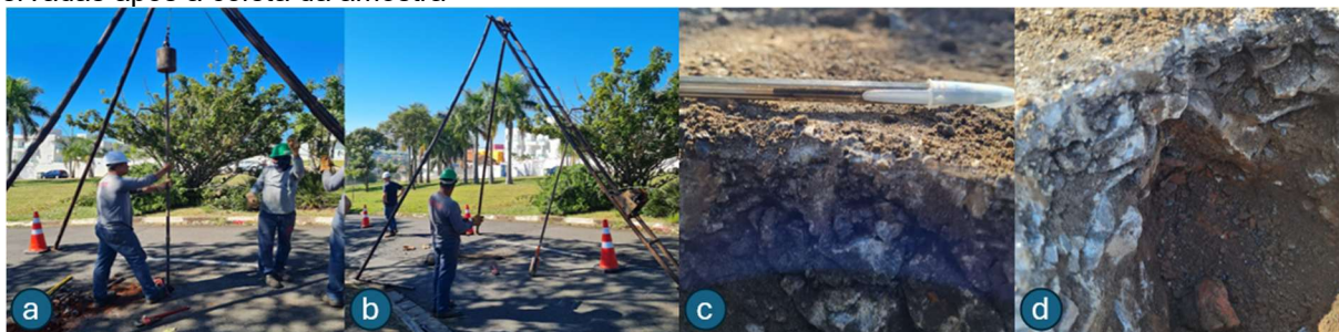
Figura 17: Sondagem – sendo, a e b) coleta do SPT e equipamentos utilizados; c e d) camadas observadas após a coleta da amostra
