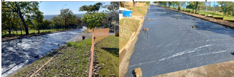
Figura 34: Processo de cura com utilização de lona e hidratação manual
