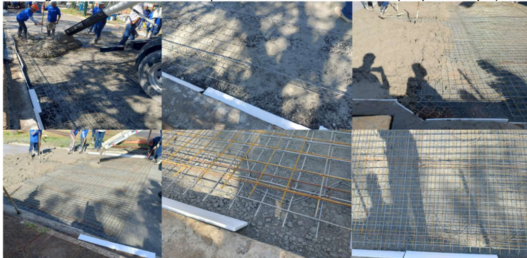
Figura 28: Concreto armado: posicionamento de armaduras (simples e dupla)
