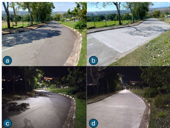
Figura 45: Iluminação do trecho, sendo: a) pavimento asfáltico período diurno, b) pavimento de concreto período diurno, c) pavimento asfáltico período noturno, d) pavimento de concreto período noturno.
