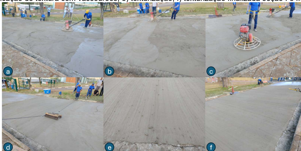
Figura 31: Acabamento, sendo: a) nivelamento inicial com alisadora circular seção I, b) nivelamento inicial com alisadora circular seção II, c) segundo nivelamento com alisadora circular, d) aplicação de textura com vassourões, e) texturização, f) texturização finalizada seção I e II.
