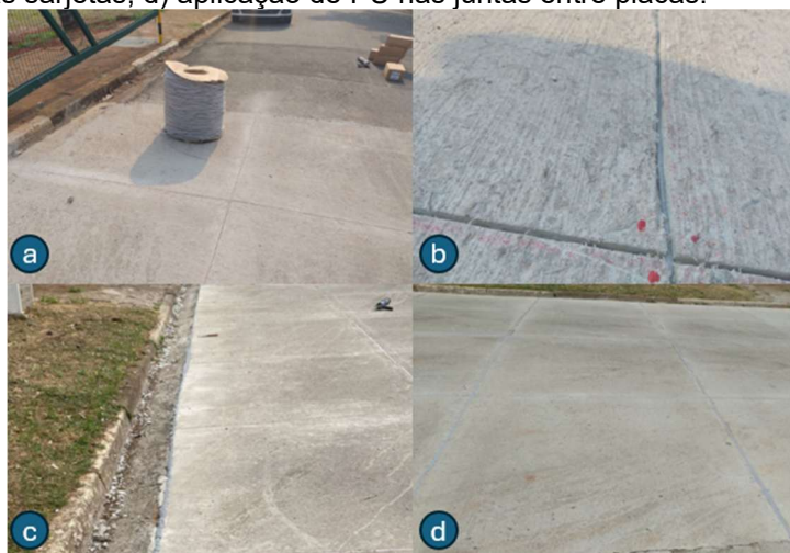
Figura 35: Selagem das juntas, sendo: a) delimitador de profundidade, b) aplicação do delimitador, c) aplicação de PU nas sarjetas, d) aplicação de PU nas juntas entre placas.
