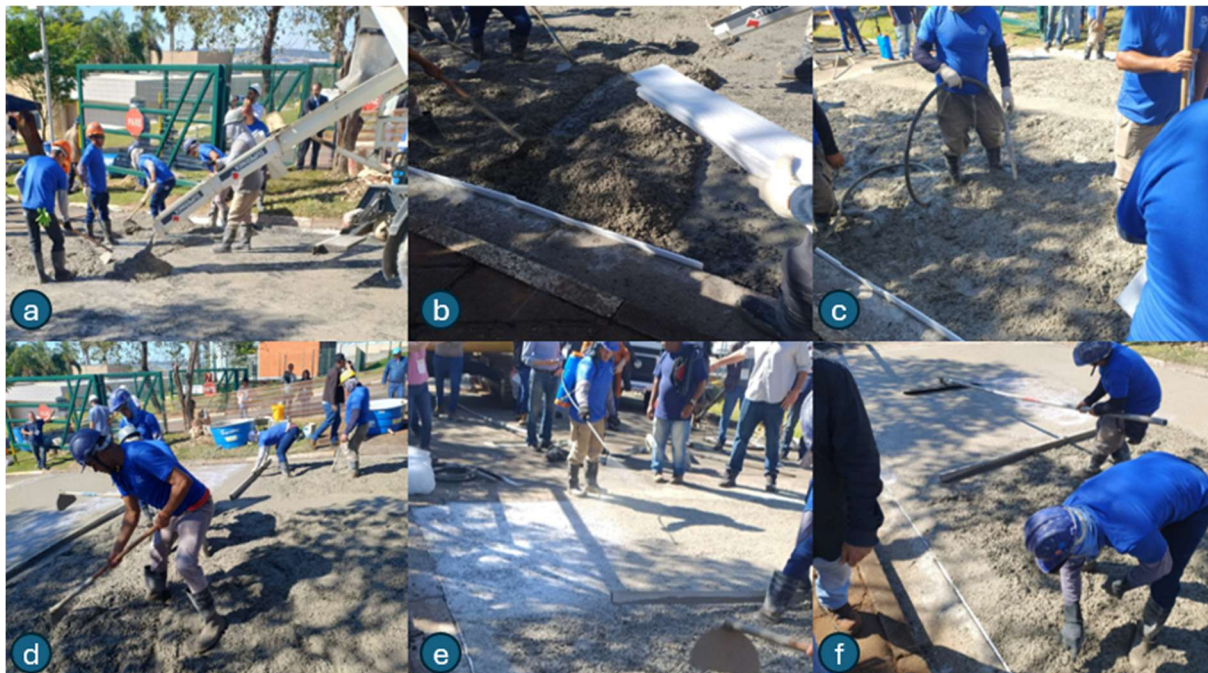
Figura 30: Processo de concretagem, sendo: a) bombeamento do concreto, b) posicionamento dos isopores, c) vibração da mistura, d) nivelamento, e) aplicação de cura intermediária, f) segundo nivelamento
