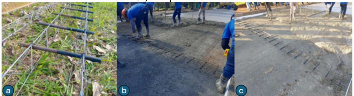
Figura 29: Barras de transferência, sendo: a) barras de transferência, b) posicionamento das barras, c) barra posicionada
