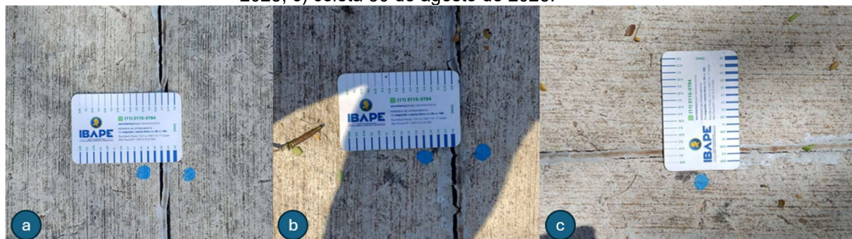
Figura 50: Abertura de junta seção I, sendo: a) coleta 30 de maio de 2025, b) coleta 26 julho de 2025, c) coleta 30 de agosto de 2025.
