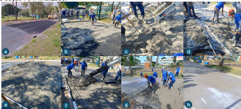
Figura 24: Etapa concretagem seção I e II, sendo: a) destaque para execução da seção I e II; b) aplicação de nata de cimento; c) bombeamento do concreto da seção I; d) nivelamento da seção I; e) posicionamento das armaduras da seção II; f) bombeamento do concreto seção II; g) nivelamento seção II; h) trecho seção I e II finalizado.
