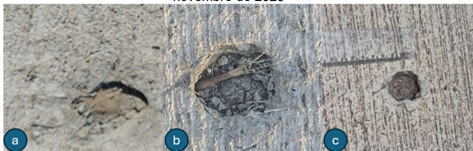
Figura 56: Evolução do buraco seção VI, sendo a) junho de 2024, b) agosto de 2024, c) novembro de 2025
