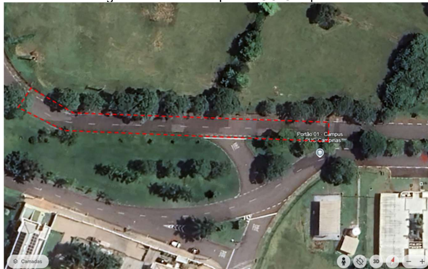
Figura 11: Trecho de pista PUC-Campinas
