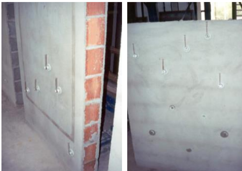
Figura 14 – Ensaio do cachimbo em vista lateral (a) e frontal (b).
