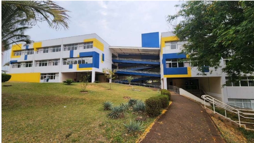
Figura 7. Fachada Norte da edificação de estudo.
