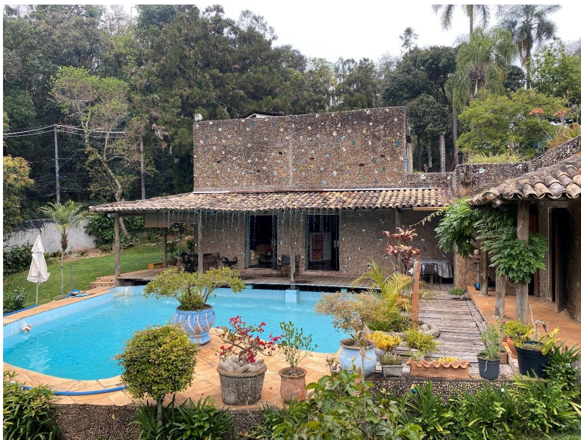
Figura 37. Vista da casa a partir da cobertura da Terracia. A vegetação proposta por Lina já não tem a mesma exuberância. As bromélias da parede foram removidas em todo o edifício. Fotografia do autor, 2025
