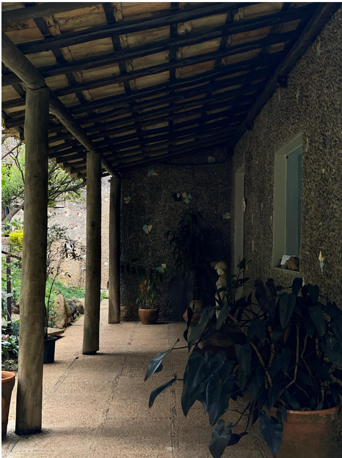
Figura 32. Vista da varanda, junto ao acesso principal da residência. Destaque para a luz do ambiente e como a penumbra é presente junto à porta. A condição do projeto, entorno e vegetação modulam a luminosidade. Fotografia do autor, 2025
