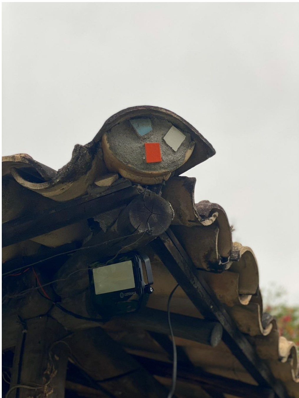
Figura 1. Detalhe de embocamento das telhas. Residência Valéria Cirell, projeto de Lina Bo Bardi. Fonte: Foto do autor, 2025
