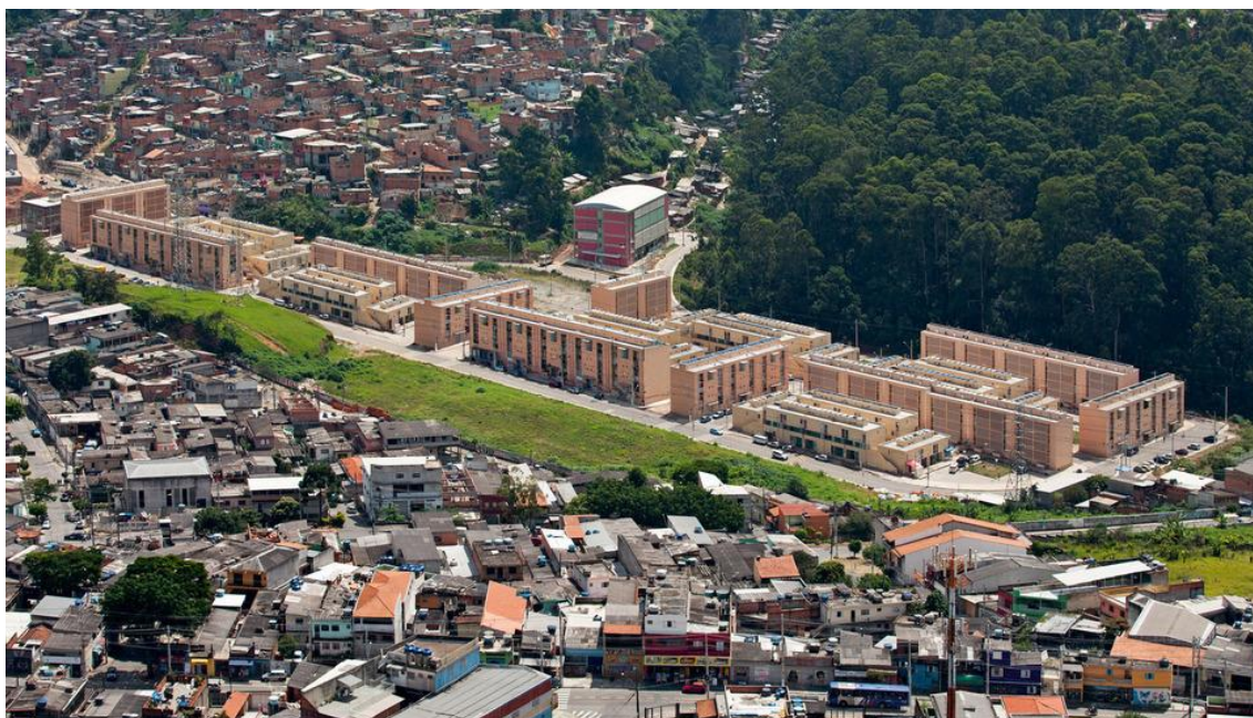
Figura 5 - Conjunto Habitacional Área de Portais.
