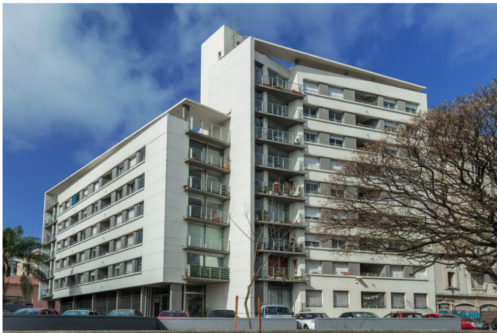
Figura 7 - Puerto Fabini - Fachada da calle 25 de agosto com a Praça Pública.
