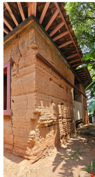
Figura 149. Ponto 3: Fachada Noroeste Tulha
