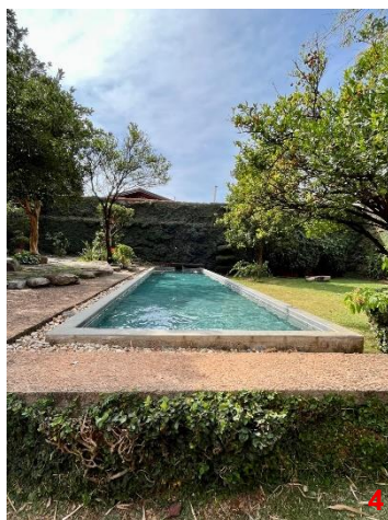
Figura 150. Ponto 4: Detalhe da piscina em seu estado atual.
