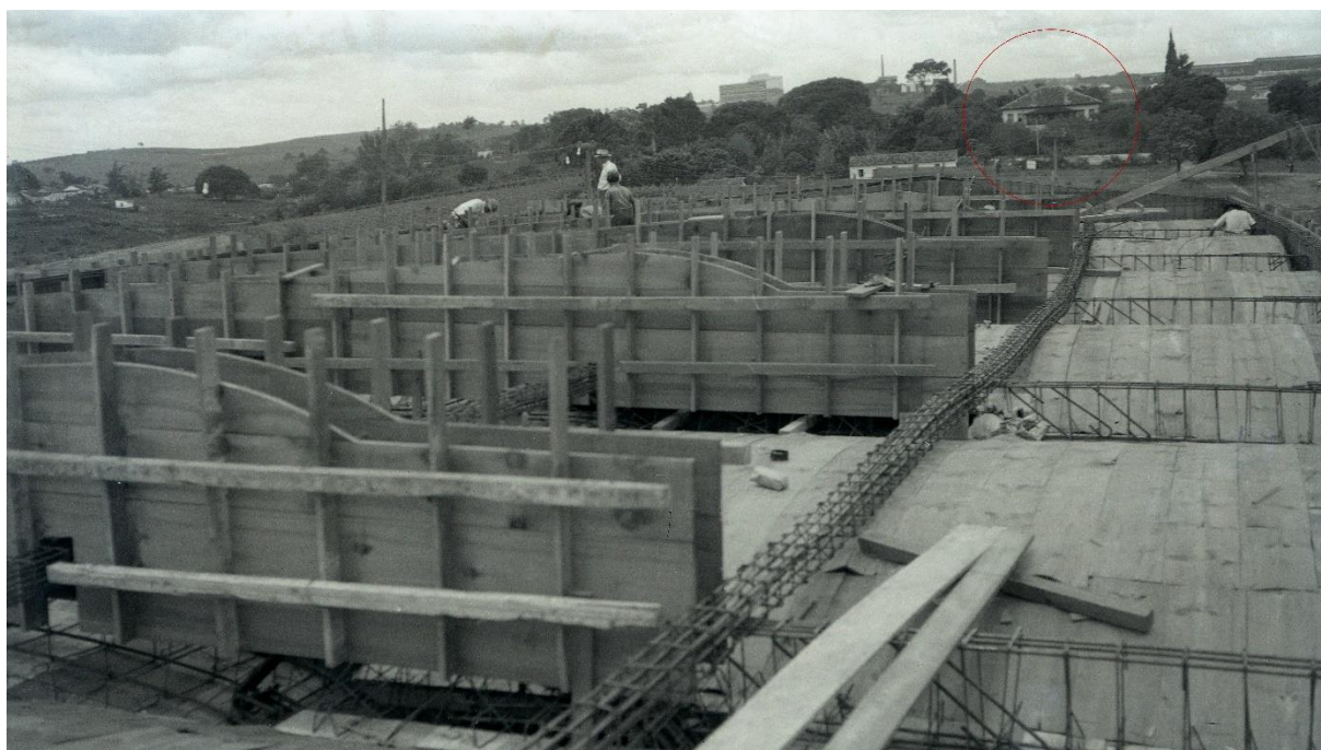
Figura 90. Construção do Estádio Brinco de Ouro da Princesa em 1953.
