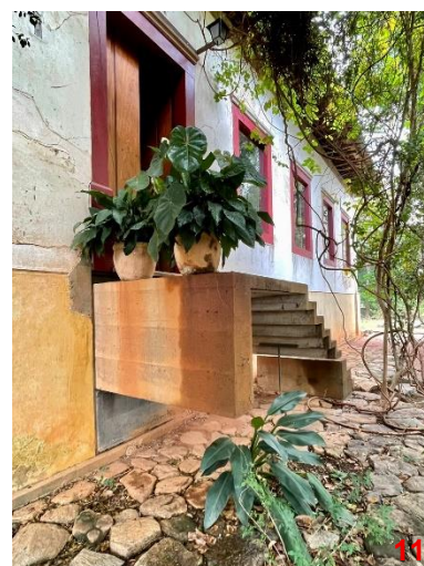
Figura 157. Ponto 11: Perspectiva da escada; nota-se a clareza estrutural do novo elemento adicionado ao bem
