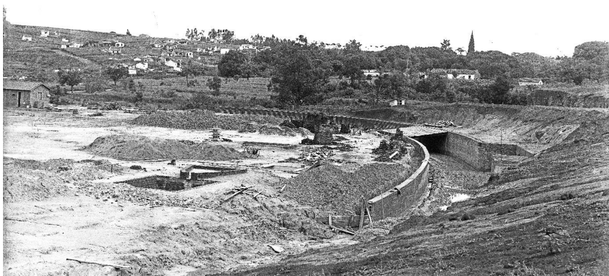
Figura 89. Construção do Estádio Brinco de Ouro da Princesa em 1951.
