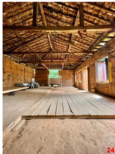
Figura 170. Ponto 24: A Tulha como síntese do percurso. Onde o jogo de tensões entre a matéria bruta e o espaço reabilitado materializa a dualidade entre o peso do tempo e a leveza da intervenção.
