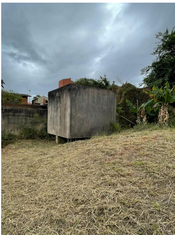
Figura 49. O cubo (lavanderia)
