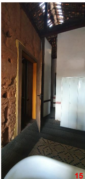
Figura 161. Ponto 15: Adaptação das alcovas em banheiros. Detalhe da porta metálica pivotante, que marca a nova camada de intervenção
