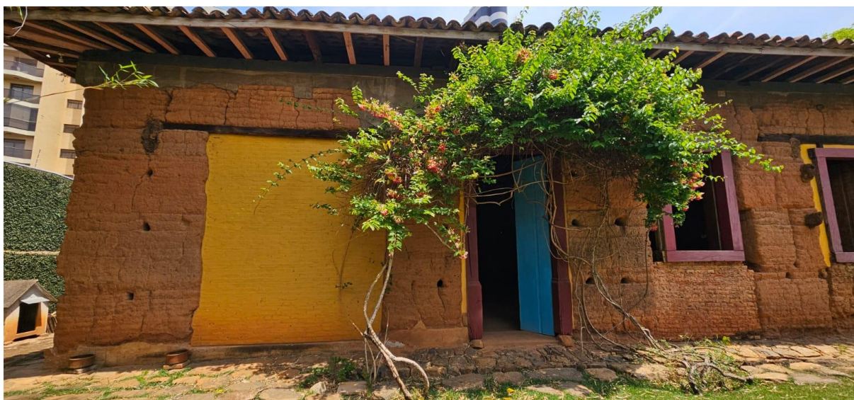
Figura 121. Fachada principal da Tulha evidenciando o fechamento em alvenaria (amarelo) e o cintamento de concreto
