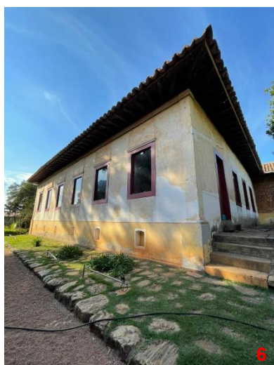
Figura 152. Ponto 6: Fachada lateral da Casa Grande. O mosaico de revestimentos revela as sucessivas camadas e ritmos das esquadrias
