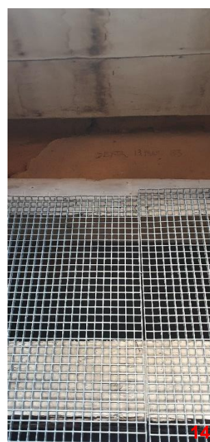
Figura 160. Ponto 14: Detalhe do piso metálico e a data da intervenção na parte superior da fotografia: 13 de maio de 1983
