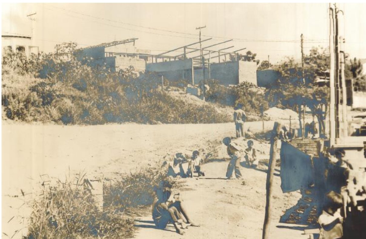
Figura 30. Centro Comunitário durante a construção.
