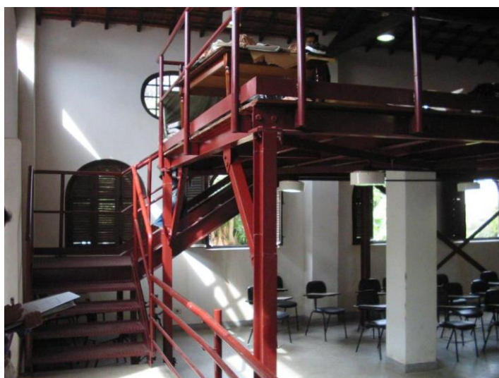
Figura 17. Detalhe do jirau metálico introduzido na última fase da restauração.
