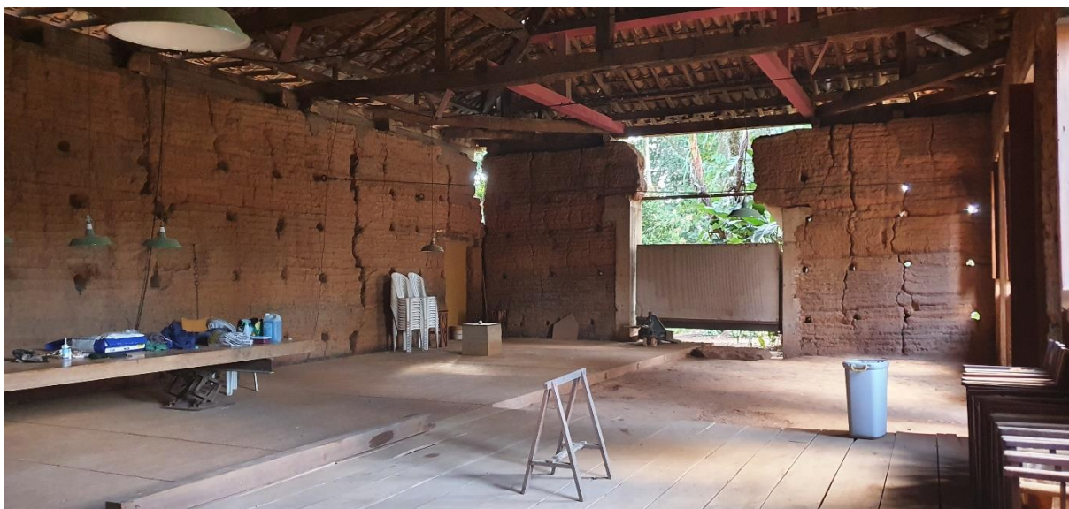
Figura 124. Interior da Tulha evidenciando as intervenções de consolidação estrutural, a estrutura da cobertura, o contrapiso de concreto e o remanescente em chão de terra. Em destaque, o local da primeira escavação arqueológica onde se revelou a fundação de uma possível parede (atualmente protegida por peças de madeira).
