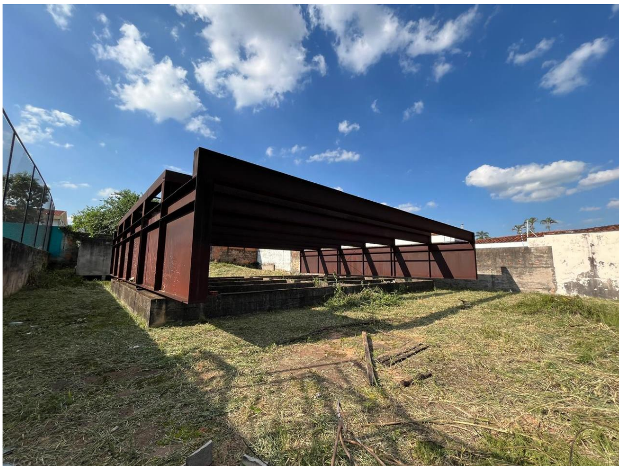
Figura 43. Vista frontal do volume principal da residência
