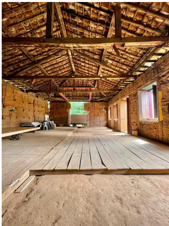
Figura 173. Espaço interno: coexistência entre a taipa de pilão e as intervenções contemporâneas
