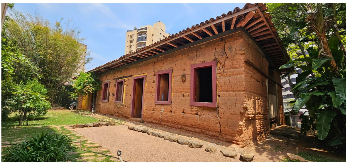
Figura 128. Fachada principal da Tulha evidenciando a intervenção contemporânea nos vãos das esquadrias, executada em concreto pintado em tom amarelo
