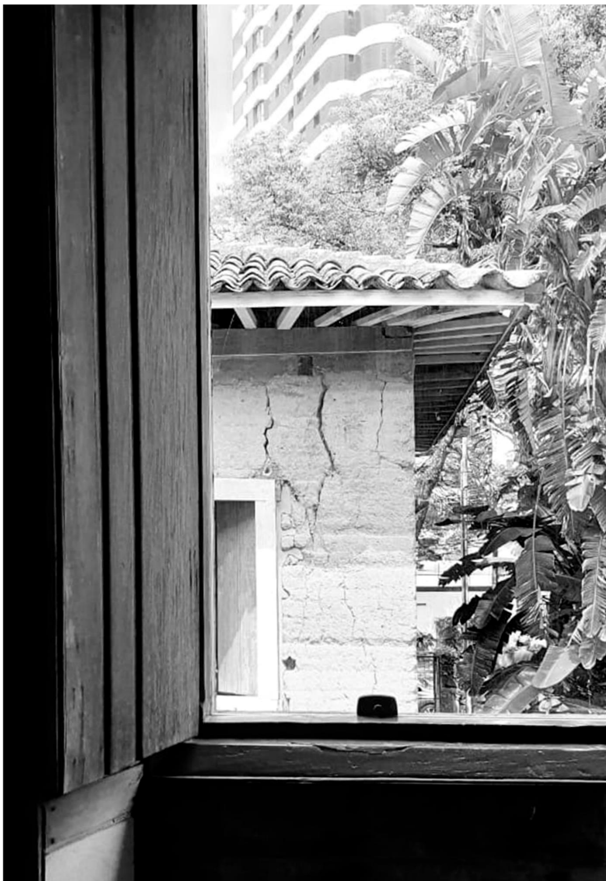
Figura 68. Casa Grande e Tulha
