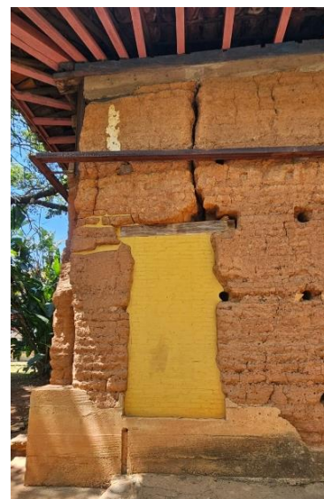
Figura 172. Detalhe da fachada: distinguibilidade da ação contemporânea.
