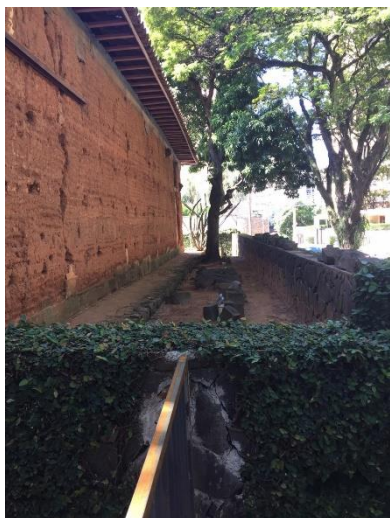
Figura 119. Fachada da Tulha com destaque para o novo muro de contenção
