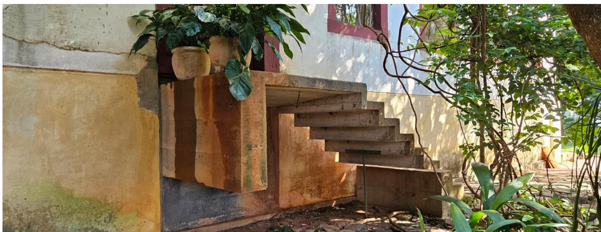
Figura 130. Reconfiguração do acesso principal: escada contemporânea em concreto incorporada após a supressão do antigo alpendre de ingresso.
