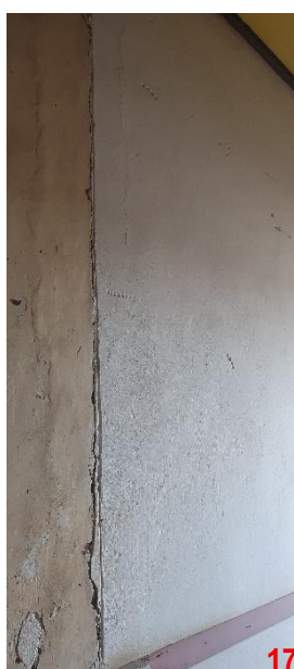
Figura 163. Ponto 17: Detalhe do encontro entre a taipa original e a recomposta. As marcas dos dedos dos artífices testemunham o processo de restauro
