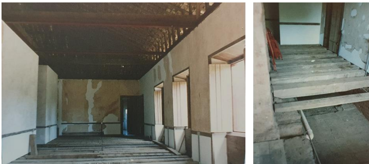
Figura 134. Mosaico fotográfico do processo de restauro documentando a supressão do assoalho original e a subsequente preparação da base para a recepção de novas infraestruturas técnicas
