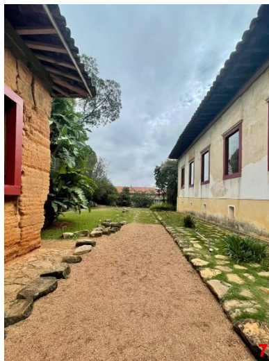
Figura 153. Ponto 7: Perspectiva do percurso entre a Casa Grande e a Tulha, evidenciando o diálogo entre as massas construídas
