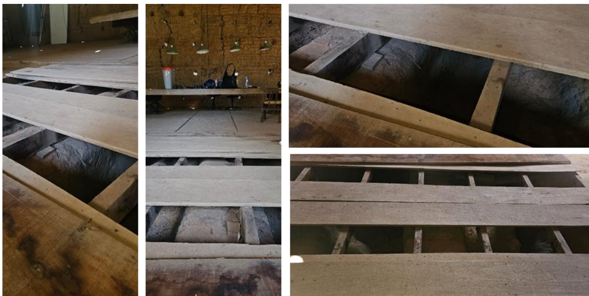
Figura 126. Mosaico fotográfico evidenciando o remanescente da fundação em taipa. Os vestígios indicam a hipótese de uma antiga parede divisória, sugerindo a compartimentação original do espaço (Condephaat, 1986, p. 45)
