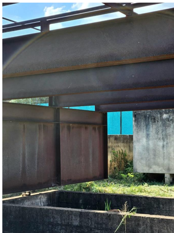
Figura 50. A estrutura metálica e a lavanderia
