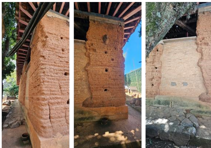
Figura 120. Mosaico fotográfico: Intervenções no segundo ponto de interrupção do cintamento (abertura na Tulha) com novo fechamento em alvenaria
