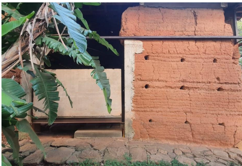
Figura 171. Exposição da taipa de pilão e preservação da matéria estratificada na fachada lateral.
