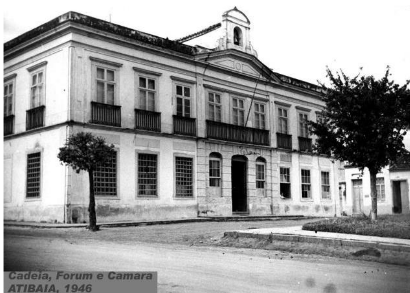
Figura 8. Casa de Câmara e Cadeia de Atibaia em situação anterior ao restauro.
