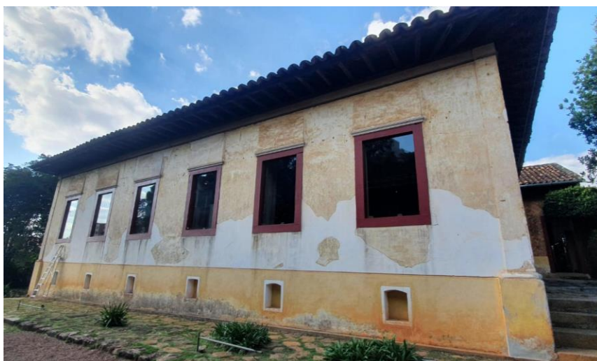
Figura 132. Fachada da Casa Grande evidenciando a articulação entre os remanescentes do revestimento original e a argamassa recomposta; destaque para o fechamento contemporâneo em vidro temperado
