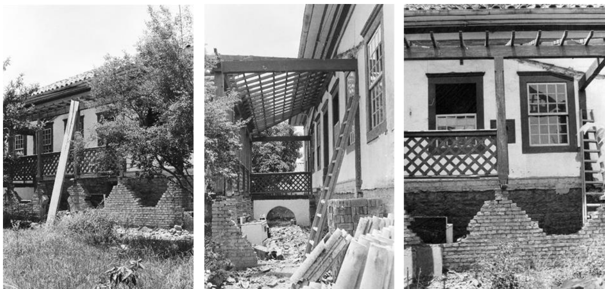
Figura 129. Sequência de registros da supressão do alpendre da Casa Grande; documentação histórica datada entre o final da década de 1970 e o início de 1980.
