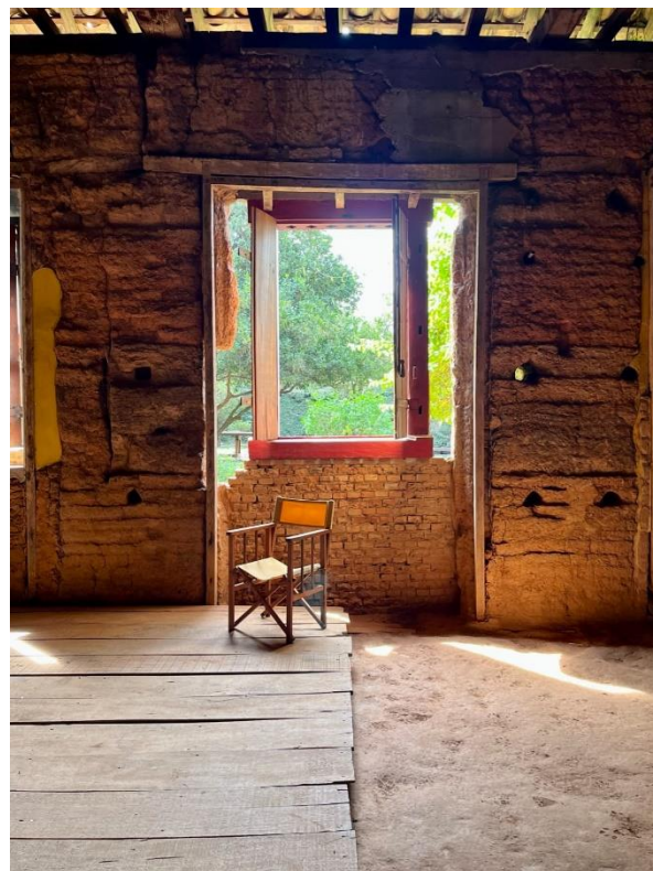
Figura 174. Enquadramento do vão original e coexistência entre a taipa de pilão e alvenaria de tijolos
