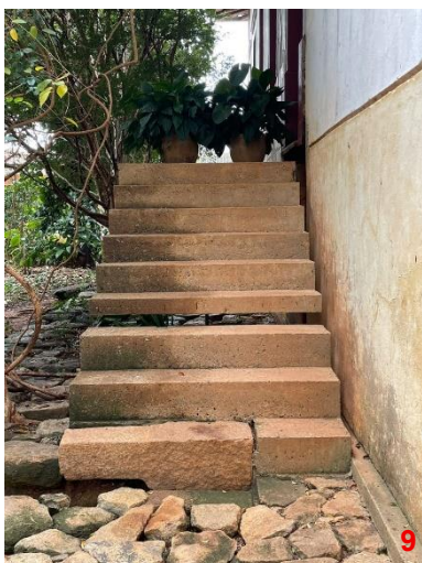
Figura 155. Ponto 9: Detalhe da escada em concreto bruto; elemento contemporâneo que garante acesso à residência
