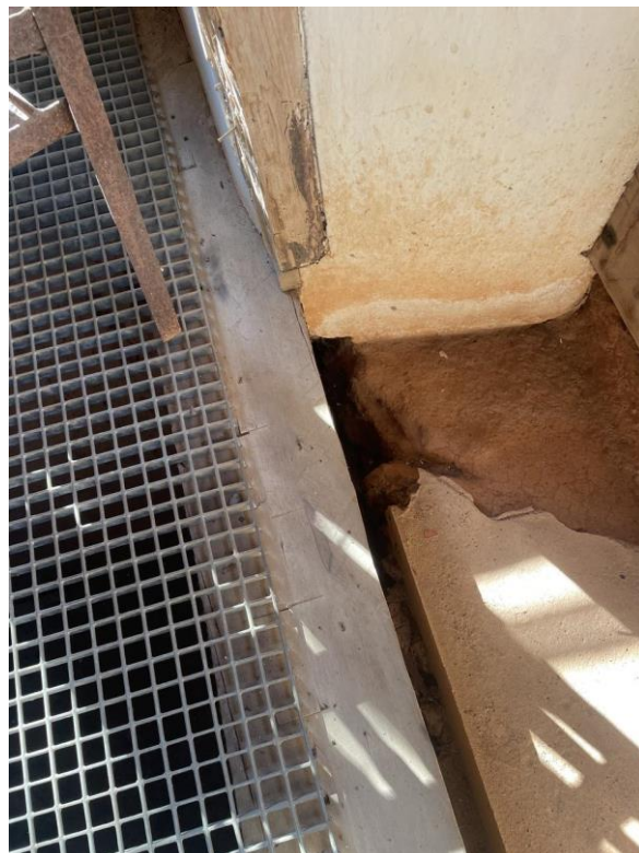
Figura 178. Detalhe do piso metálico da Casa Grande
