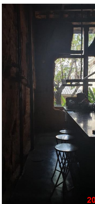
Figura 166. Ponto 20: Vista da cozinha. Detalhe do encontro entre a taipa e o vidro temperado, com instalações aparentes e independentes da matéria original
