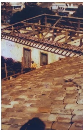
Figura 131. Processo de restauro da cobertura da Casa Grande
