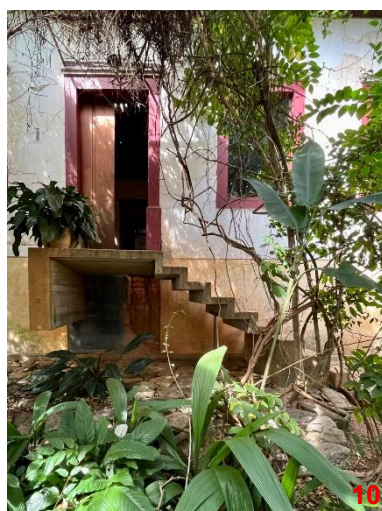
Figura 156. Ponto 10: Vista lateral da escada e sua inserção na fachada nordeste da Casa Grande
