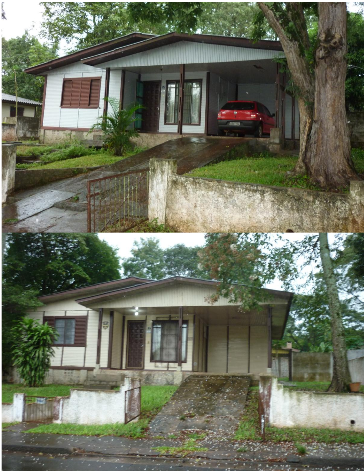
Figura 47. Fotografia da fachada da casa tipo 4' MI em Madeira
