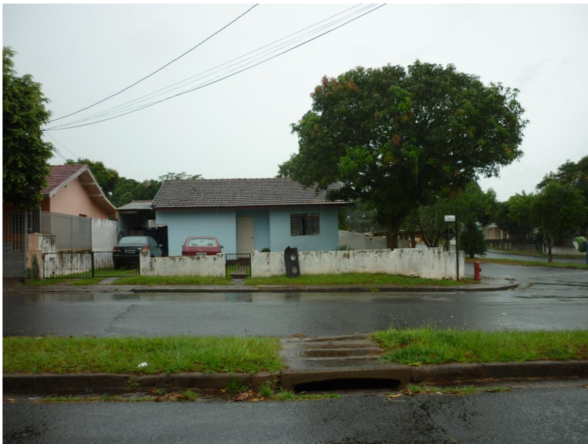
Figura 49. Fotografia da fachada de casa de alvenaria tipo 09
