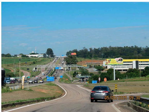
1. Empreendimentos empresariais e logísticos às margens da Rodovia Santos Dumont, a exemplo do Centro de Tratamento de Cartas e Encomendas (CTCE) do Correios, ao lado direito, e a sede regional da empresa John Deere, ao lado esquerdo, no fundo
