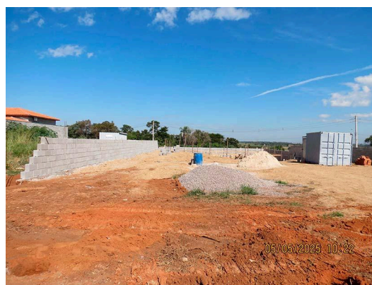
10. Construção em andamento num lote de esquina no Loteamento Recreio Campestre Internacional Viracopos, predominantemente residencial, já em Indaiatuba.
