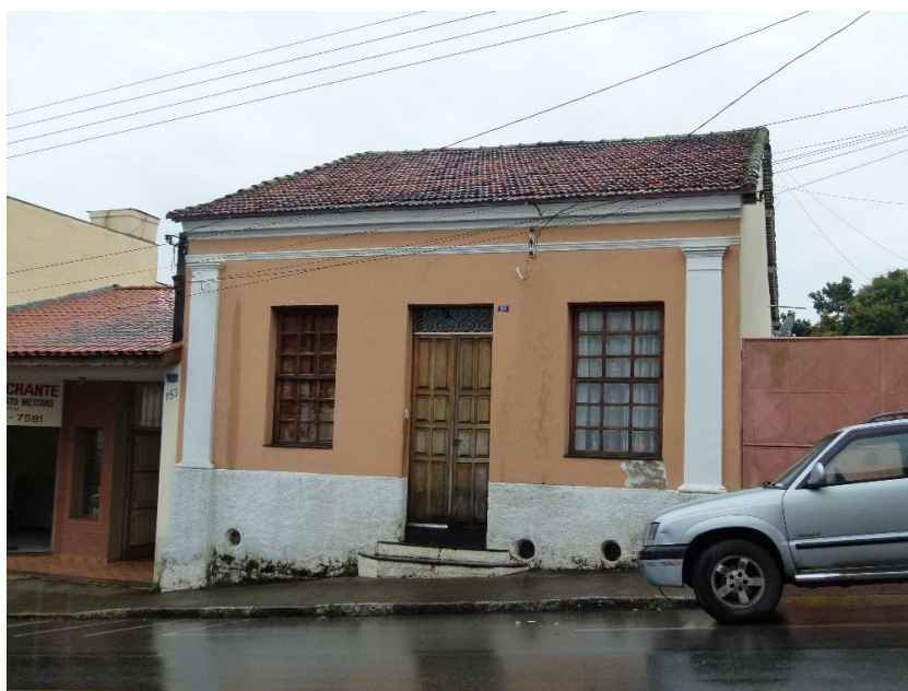
Figura 94 - Casa com porão em Morungaba-SP. Fonte: acervo da autora.
