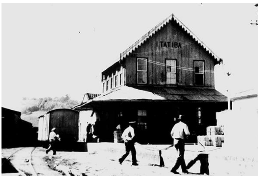
Figura 33 – Estação final do ramal da ferrovia itatibense. Fonte: Acervo Parodi.
