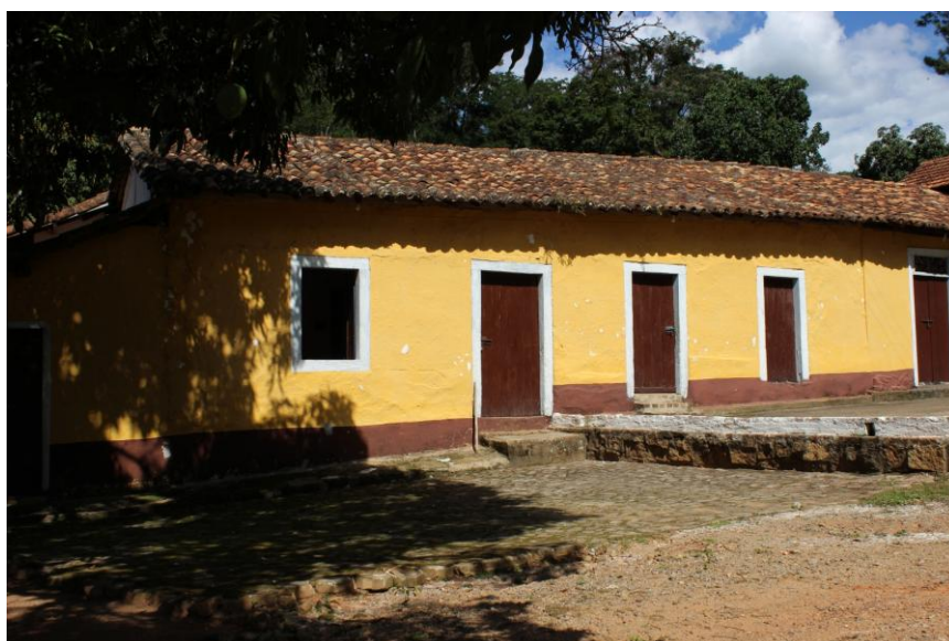
Figura 91 – Remanescente de casas de colonos que pertenceram à Fazenda Santa Ana, em Morungaba-SP. O remanescente foi construído nas técnicas de taipa de pilão para as paredes externas e taipa de mão para as paredes internas. Também há trechos da construção que contêm tijolos, e em alguns locais do alicerce encontra-se pedras. Segundo os moradores atuais da propriedade, havia no total doze casas dispostas lado a lado em um aclave, mas que já estavam em estado de deterioração em meados do século XX. Fonte: Acervo da autora, 2025.
