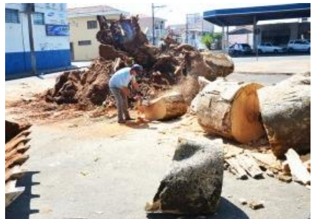
Figura 39: Remoção da figueira pela municipalidade.
