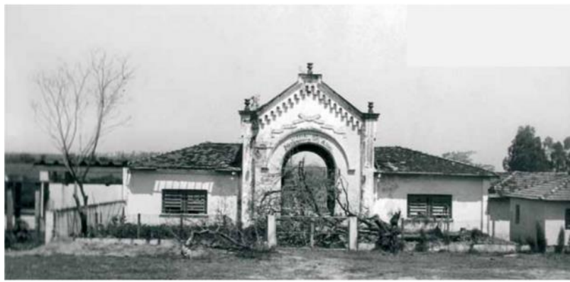
Figura 11: As instalações originais do Matadouro Municipal de Rio Claro. 1920.
