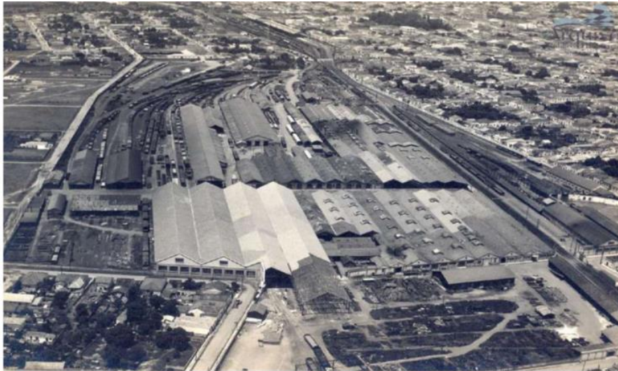
Figura 4: Vista aérea das oficinas de CPEF. Data Indefinida.
