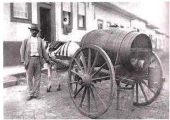
Figura 10: Agueiro - Foto tirada no início do século XX. Fonte: Arquivo Público e Histórico do Município de Rio Claro "Oscar de Arruda Penteadado".
