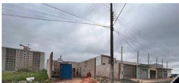
Figura 104: Ocupação de terrenos vazios próximo a feira. Fonte: acervo da autora, 2023.
