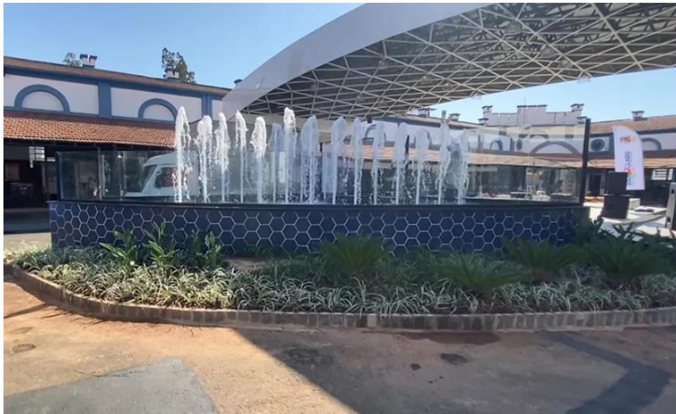
Figura 15: Obra concluída na intervenção no Mercado Municipal de Rio Claro. Fonte: Edijan Del Santo/EPTV, 2023.
