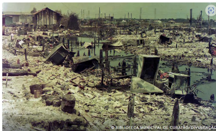
Figura 8 - Vila Socó após o incêndio
