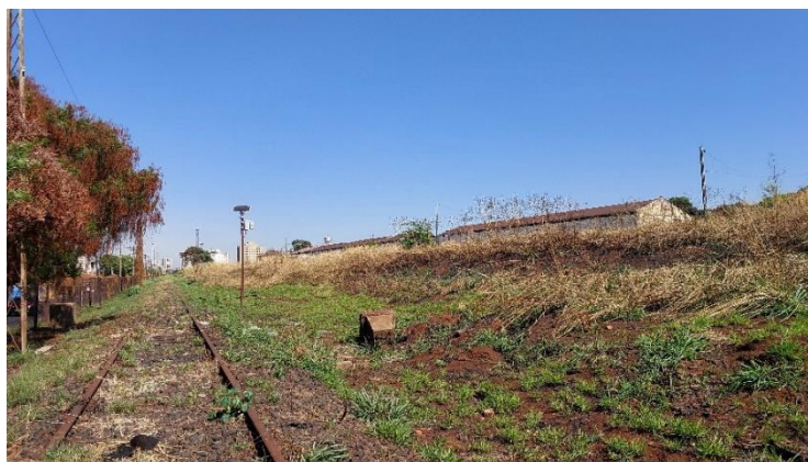
Figura 69. Vista da antiga Superintendência dos Serviços do Café e posterior armazém da Ceagesp, com o trilho também visível. Foto tirada da posição C. Fonte: Autora, 2025.
