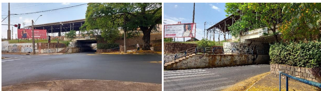
Figura 22. Vista a partir da Av. São Paulo, observando-se o pontilhão dos trilhos. Cruzamento que leva à Vila Xavier. Fonte: Autora, 2025.
