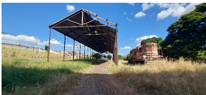
Figura 90. Cobertura de antiga plataforma. Foto tirada da posição J. Fonte: Autora, 2025.
