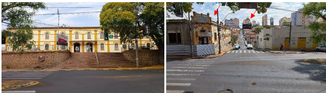
Figura 29. Acesso 2 ao Museu – escadaria principal que se localiza na direção da Av. Brasil. Também é possível observar o antigo Hotel São Bento em ruínas, e a Igreja Matriz ao fundo (indicados pelas setas).
