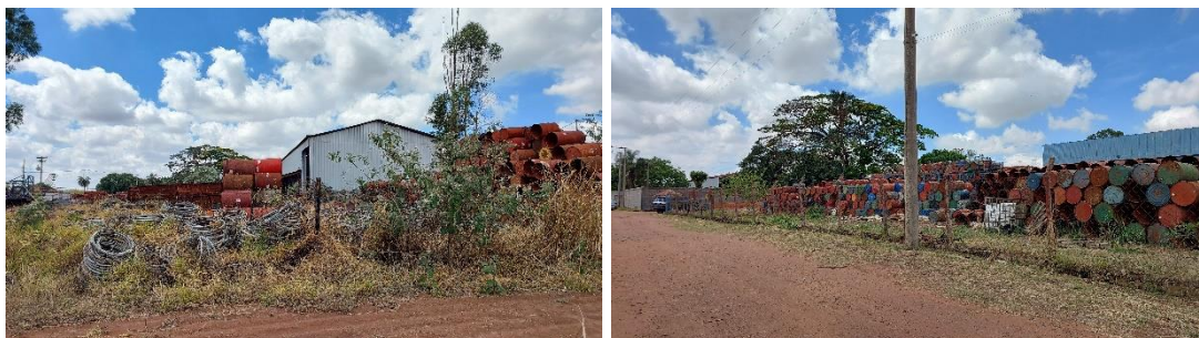
Figura 46. Instalações fabris na parte posterior da estação. Fotos tiradas nas posições D e E. Fonte: Autora, 2025.
