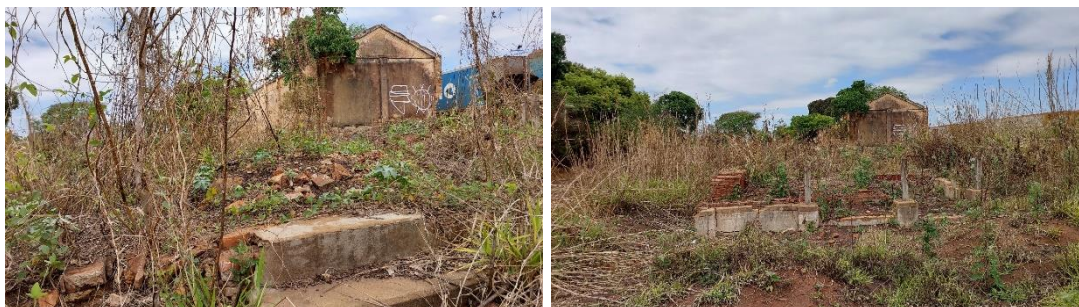
Figura 60. Vestígios de construções demolidas na lateral da estação. Fotos tiradas na posição H. Fonte: Autora, 2025.
