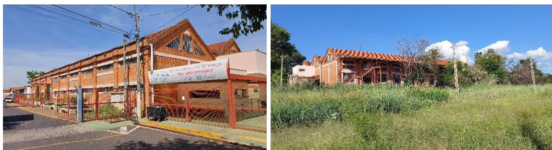
Figura 81. Vistas para o armazém onde hoje abriga a Escola Municipal de Dança Iracema Nogueira. A foto da direita foi tirada a partir da plataforma da estação, atual Museu Ferroviário, sendo possível identificar a escola na margem oposta das linhas férreas, já cobertas pela vegetação. Fotos tiradas das posições F e G.
