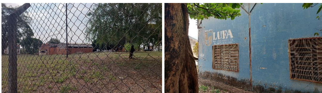
Figura 96. Ruínas da Cooperativa de Cana e Café (esquerda) e edificação da indústria LUFA, aparentemente também inutilizada (direita). Fotos tiradas das posições B e C. Fonte: Autora, 2025.
