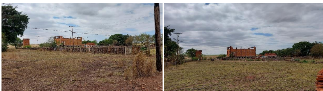
Figura 57. Subestação de energia elétrica. Fotos tiradas na posição C. Fonte: Autora, 2025.
