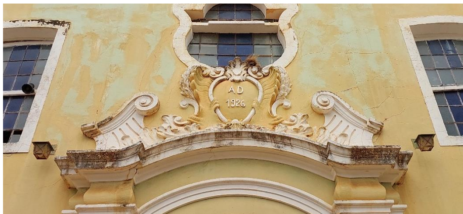
Figura 113. Capela do Sagrado Coração de Jesus, com destaque para a data na fachada: 1926, possivelmente indicando o ano de sua inauguração. Fotos tiradas da posição F.
