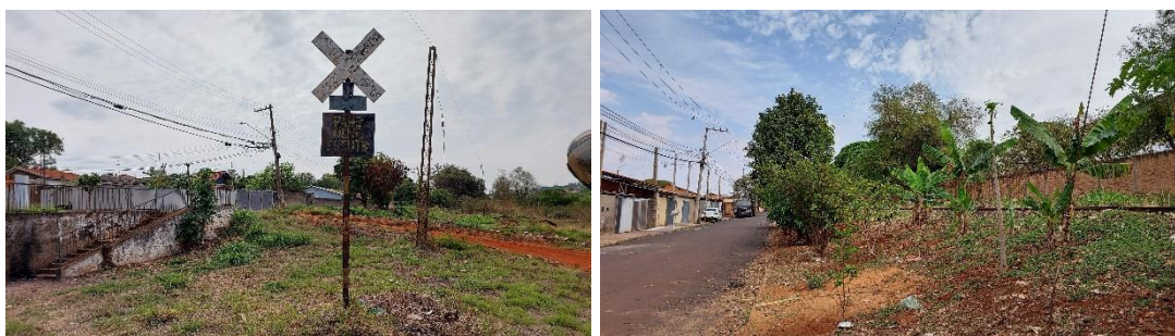
Figura 74. Placa de cruzamento, poste e o trilho, pouco visível em meio à vegetação existente. Fotos tiradas das posições G e H.
