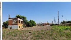
2- Cabine de controle e armazém
