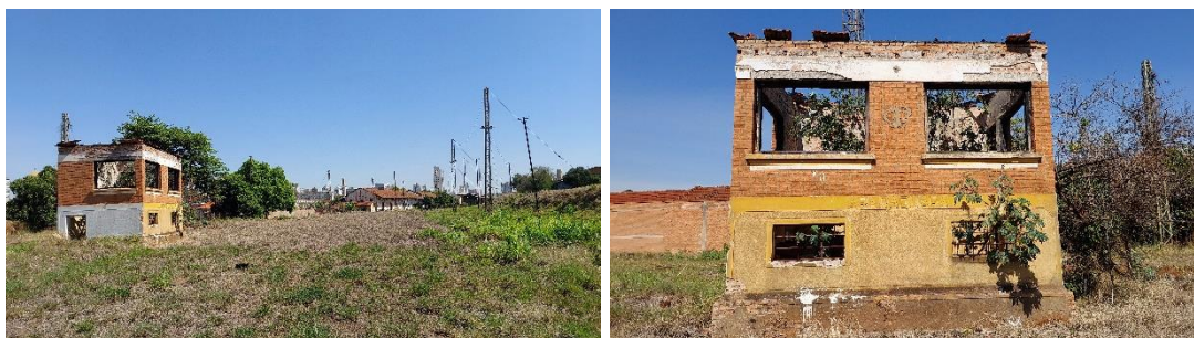
Figura 78. Cabine de controle da Estação Araraquara da CPEF. Fotos tiradas da posição A.
