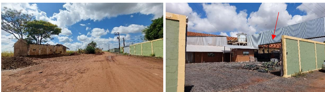
Figura 47. Instalações fabris na parte posterior da estação. Indicação da parte visível do antigo galpão. Fotos tiradas nas posições F e G. Fonte: Autora, 2025.
