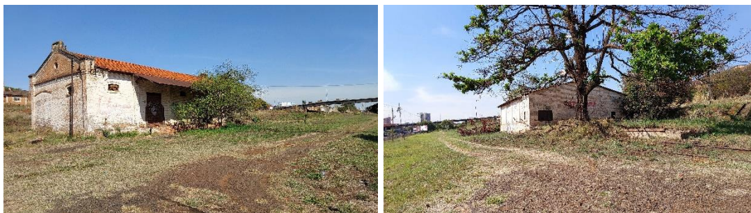
Figura 91. Ruínas de antigo armazém e oficina do telégrafo. Fotos tiradas da posição K. Fonte: Autora, 2025.
