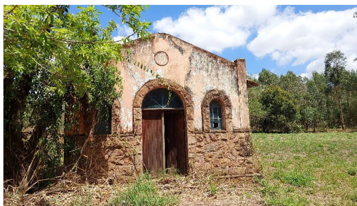
Figura 54. Capela em propriedade particular abandonada. Foto tirada da posição F.
