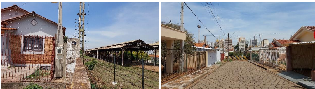
Figura 89. Conjunto de casas destinadas aos funcionários da EFA, lindeiras à ferrovia. É possível identificar o emblema presente da fachada da foto da esquerda. Fotos tiradas da posição I. Fonte: Autora, 2025.
