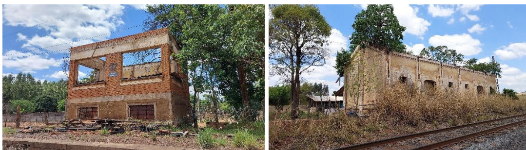
Figura 52. Cabine de controle da CPEF e antiga Estação Fortaleza. Fotos tiradas nas posições B e C. Fonte: Autora, 2025.
