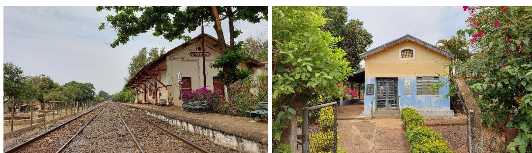
Figura 111. Estação Bueno de Andrada e Subprefeitura. Fotos tiradas da posição C. Fonte: Autora, 2025.
