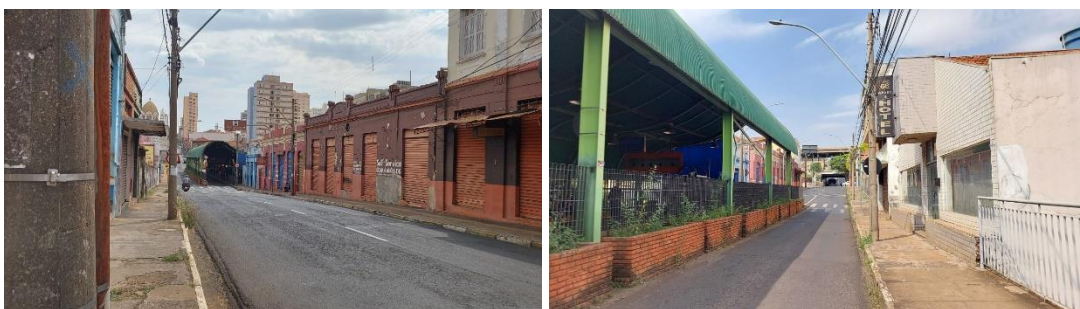
Figura 24. Vista da Av. São Paulo, sendo possível identificar o Terminal de Integração de ônibus muito próximo ao Museu. Fonte: Autora, 2025.
