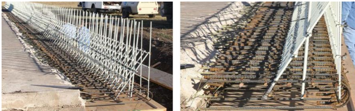
Figura 1: Reforço de GFRP em barreiras de ponte
