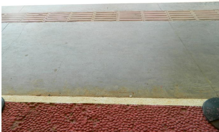
Figura 21 Detalhe do degrau do piso
