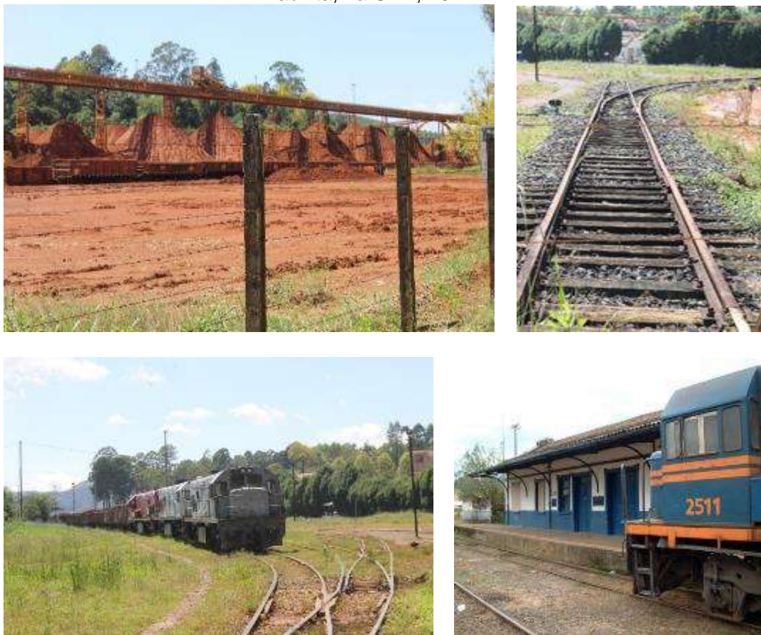
Figuras 224. Pilhas de minério bauxita na CBA, 2018. Paisagem férrea com estação Bauxita, na CBA, 2011.
