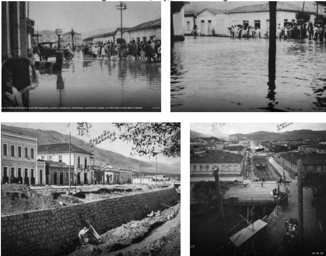
Figura 226. Enchente de 1926, na Rua Marquês de Paraná, atual Assis Figueiredo. Ao centro, imagens das obras sanitárias no Ribeirão de Caldas e rio que passava embaixo da antiga rua Bahia, hoje, Prefeito Chagas.
