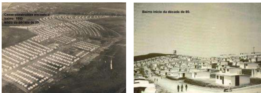
Figuras 232. Implantação do Conjunto Habitacional PedroAffonso Junqueira e detalhe das moradias, década de 1980.
