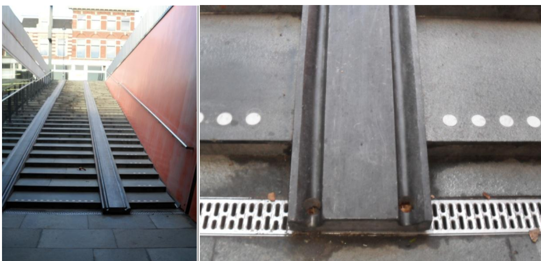
Figura 4: Auxílio para subir a escada com bicicleta, para sair ou entrar no estacionamento de bicicleta da estação de trem. Fonte: Arquivo da autora.
