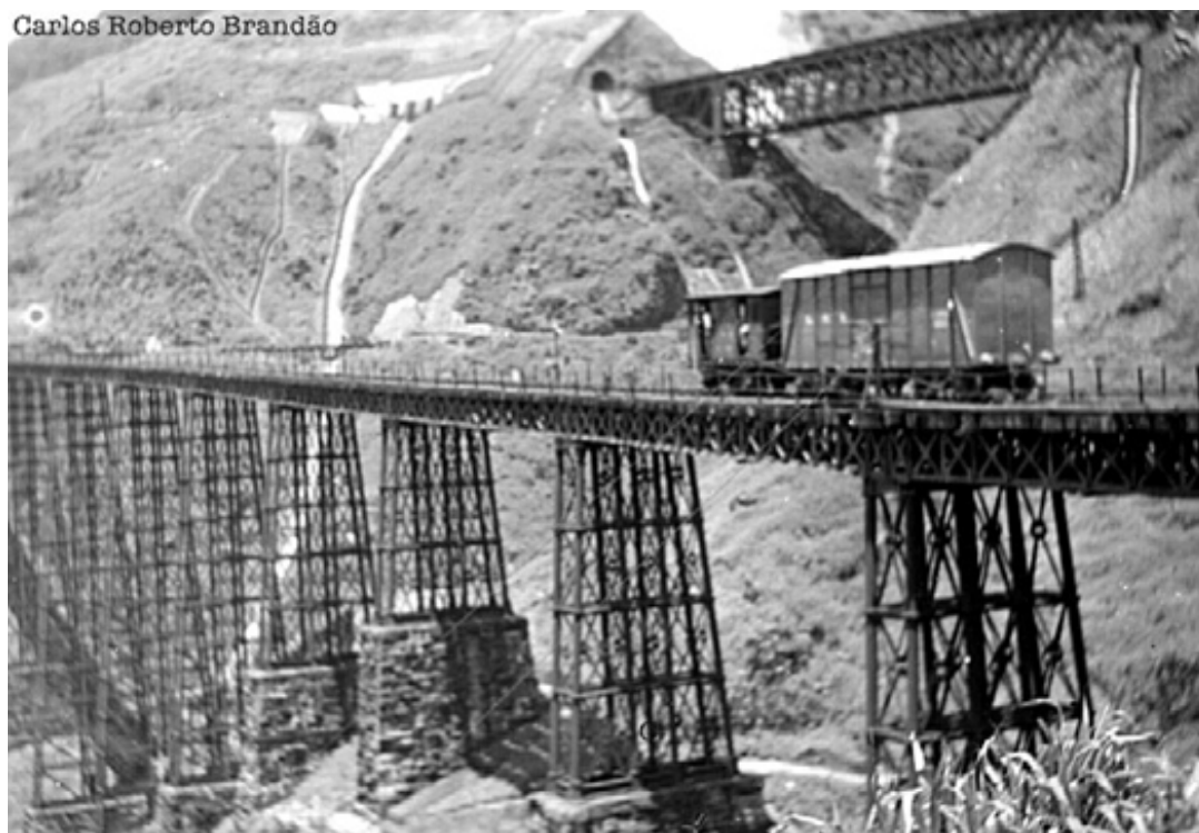
Figura 11 Uma locomotiva cruzando o Viaduto “Grotta Funda” na linha da Serra Velha. O vagão mostra as iniciais da “S.P.R.” (São Paulo Railway). Provavelmente esta foto foi feita durante os anos 40. Foto da coleção de Carlos Roberto Brandão, de Osasco SP. Disponível em: < http://www.pell.portland.or.us/~efbrazil/spr_serravelha.html >. Acesso em: mar. 2007.
