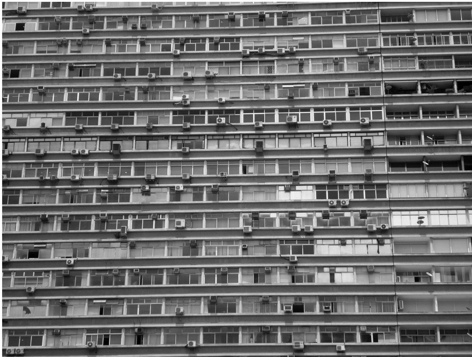
150 Conjunto Nacional, fachada da lâmina voltada para a Avenida Paulista. Foto da autora, 2015.
