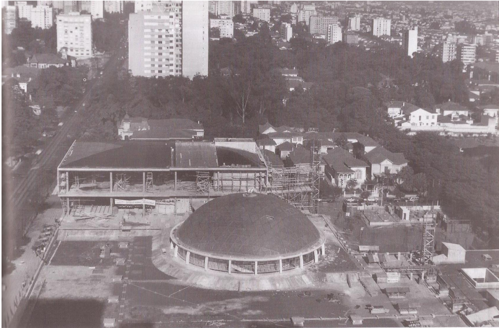
168 Construção do pavilhão do projeto inicial e cobertura geodésica. Fonte: < http://www.condominioconjutonacional.com.br >
