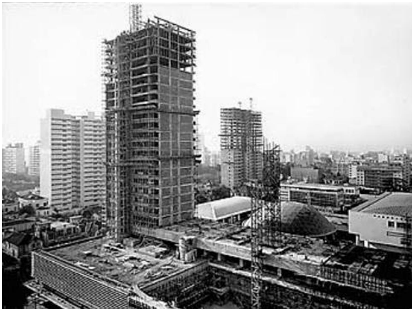
161 Acima, foto da construção do Bloco Guayupιά, sobre vigas de transição. Fonte: < http://www.condominioconjuntacional.com.br >
