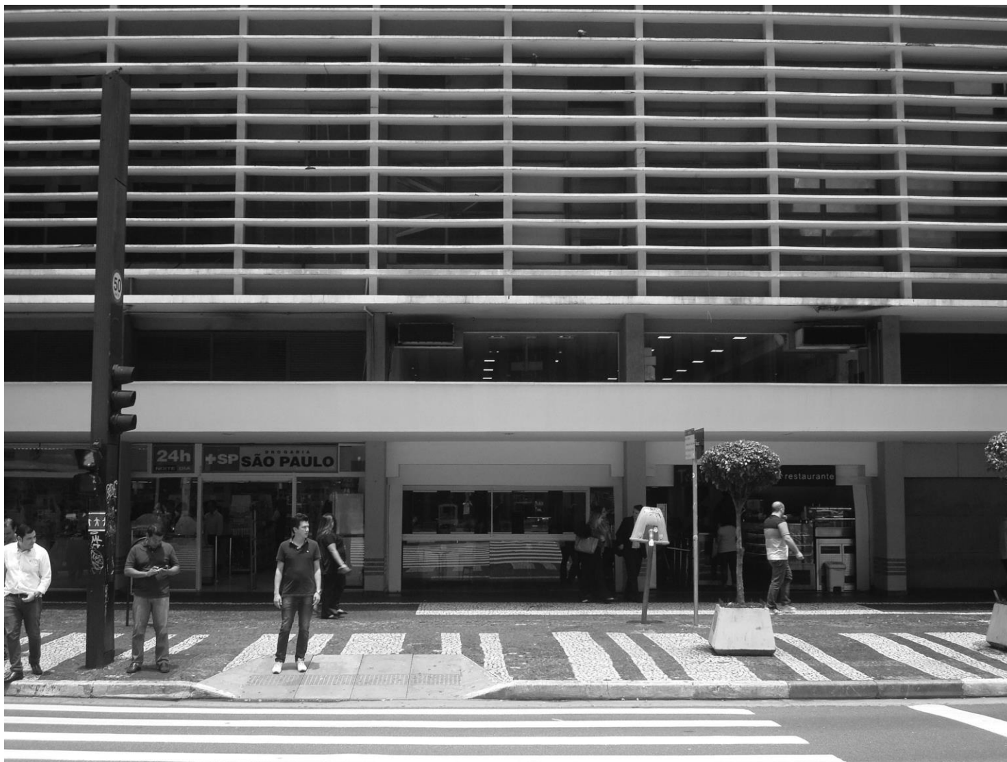
139 Marquise do Conjunto Nacional. Foto fachada Avenida Paulista. Foto da autora, 2015.
