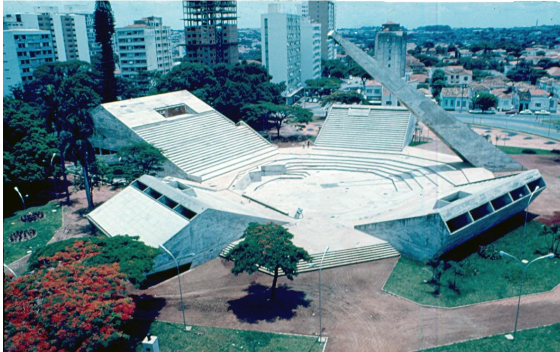
Figura 4: Centro de Convivência recém-construído.
