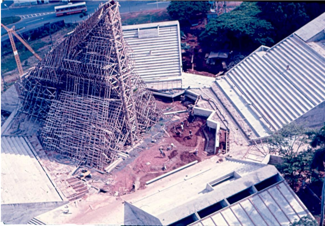
Figura 3: Construção do Centro de Convivência.
