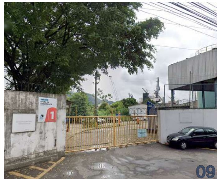
Acesso ao Porto de Vila Velha. Falta de acesso à orla (Fonte Street View)
