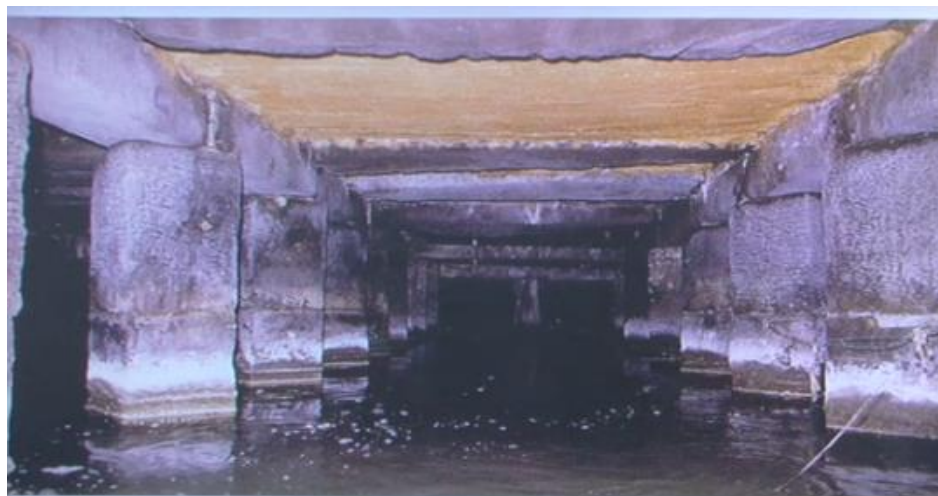
Figura 12: Situação das estruturas antes da intervenção
