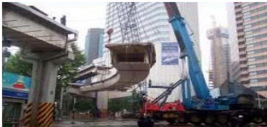
Figura 14: Obra de demolição da via expressa, região central de Seul.
