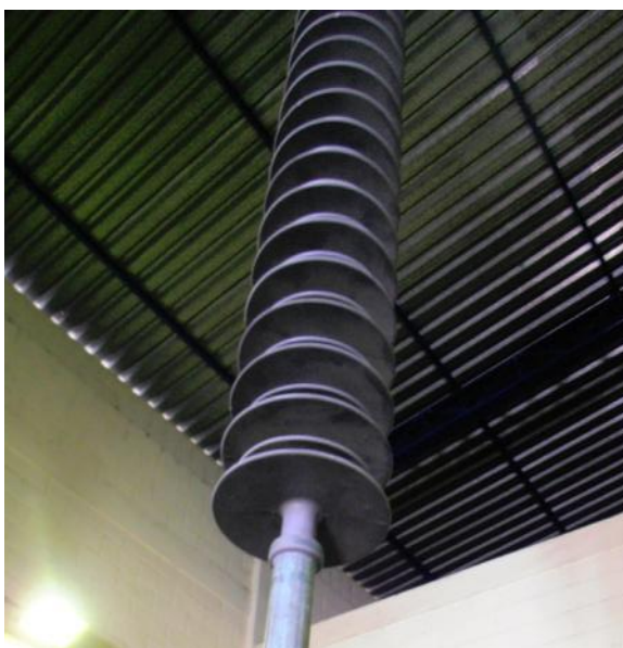
Figura 124. Isolador sem anel anti-corona
