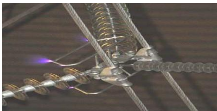
Figura 19. Efeito Corona em uma cadeia de isoladores (MELLO, 2007).
