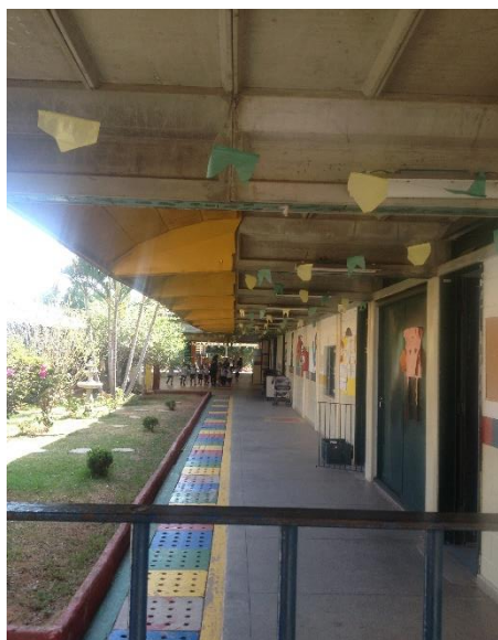
Figura 40 - Portão de Acesso EI-EF
