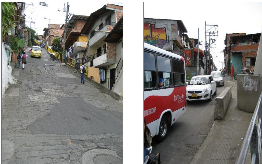
Figura 73 Acessibilidade de pedestres prejudicada, com necessidade de adaptação, Medellín, Co. Fotos: Beatriz Bueno Brandão, 2017.
