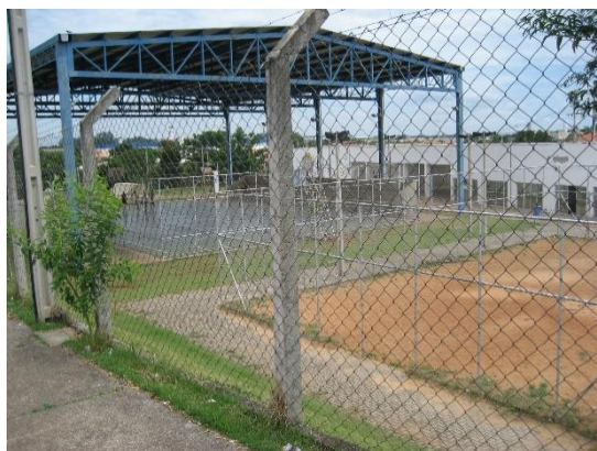
Figura 54 CEU Vila Esperança: quadras e edifício multifuncional. Foto: Beatriz Bueno Brandão, 2018.
