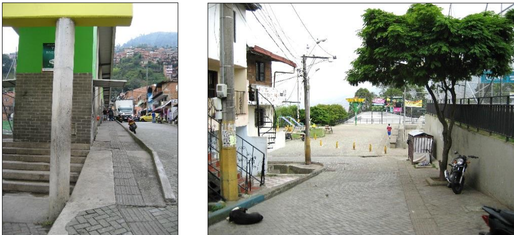
Figura 63 Unidade Desportiva Granizal: a) rua 102, compartilhada e com piso tátil direcional junto ao campo de futebol; b) rua 102, compartilhada e com piso tátil direcional em direção aos demais equipamentos esportivos e de lazer. Foto: Beatriz Bueno Brandão, 2017.
