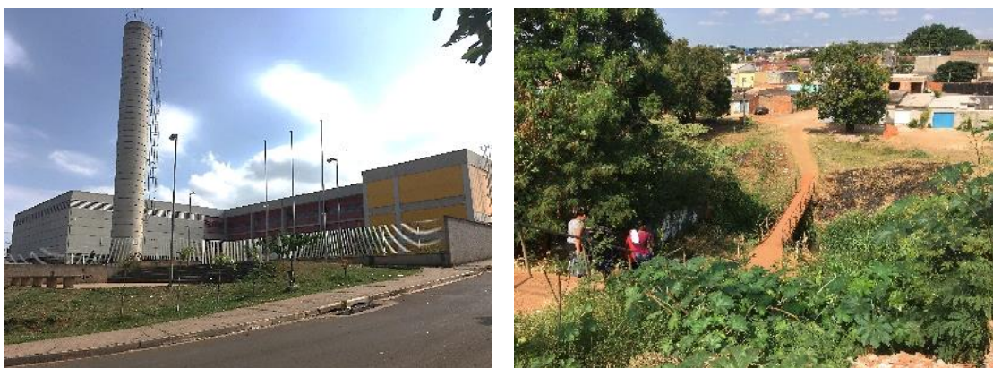
Figura 60 a) escadaria para o acesso principal; b) escadaria e ponte travessia Ribeirão Quilombo. Foto: Beatriz Bueno Brandão, 2017.
