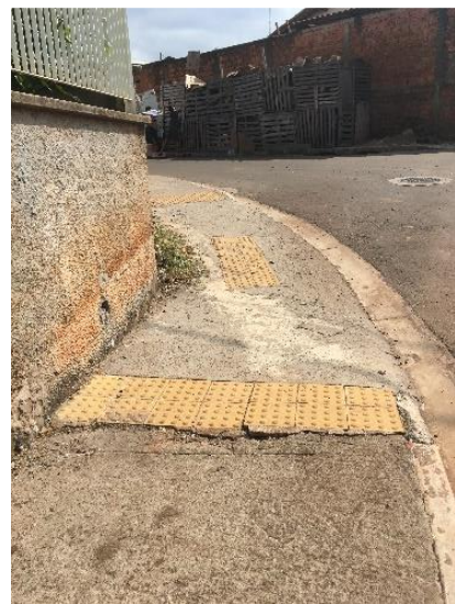
Figura 61 a) rebaixamento de calçada e rampa; b) rebaixamento de calçada estreita. Fotos: Beatriz Bueno Brandão, 2017.
