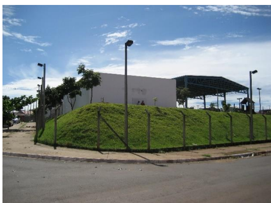
Figura 40 Vista externa: edifício e quadra do CEU Vila Esperança. Foto: Beatriz Bueno Brandão, 2017.
