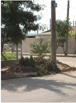
Figura 48 a) calçada com resíduos; b) rebaixamento de calçada inadequado para a travessia de pedestres. Fotos: Beatriz Bueno Brandão, 2017.
