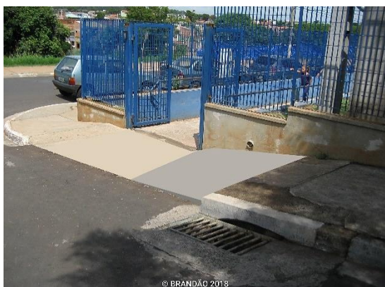
Figura 76 Rebaixo de calçada da Nave Mãe Governador Eduardo Campos, Vila Esperança, Campinas, SP. Foto: Beatriz Bueno Brandão, com intervenção da autora, 2017.
