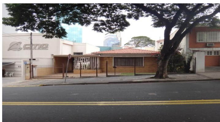
Figura 115 - Imagem fotográfica da casa nº 56 na avenida Dr. Carlos Stevenson, na Nova Campinas, apontada por Juliano por ter sido construída em 1955
