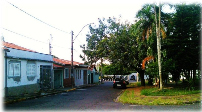
Figura 105 - Imagem das fachadas e praça da Vila Estanislau mostrando que as unidades não pressupunham na área frontal espaço para automóveis e como são usadas na atualidade
